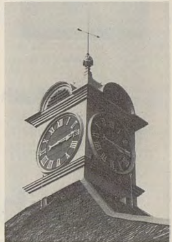
Das barocke Türmchen auf dem Rathaus strahlt nach der Renovation in neuem Glanz
