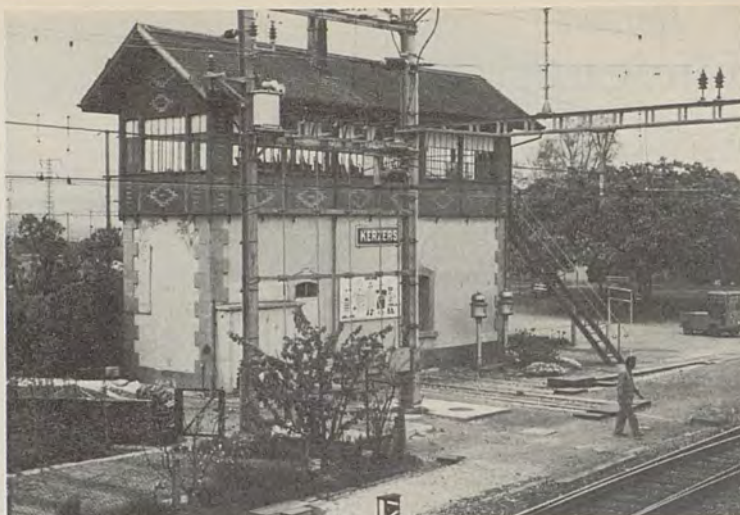
Das Stellwerk in Kerzers. Von hier aus werden die Weichen und Signale gestellt. (Fotos Ueli Gutknecht)
