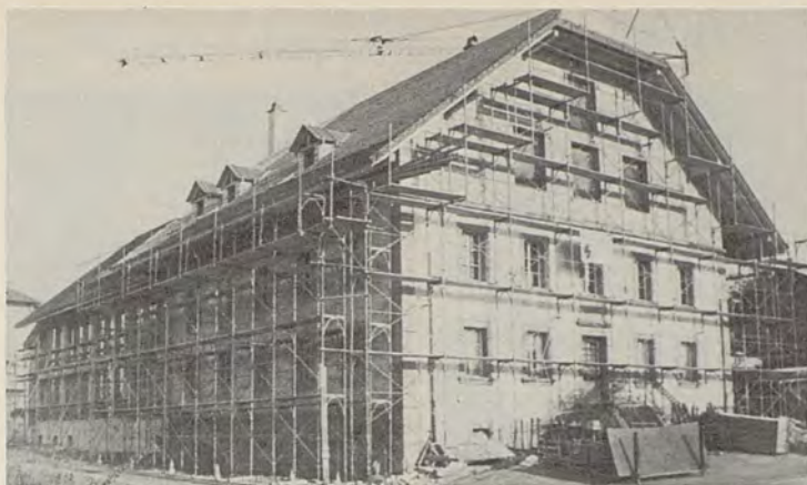
Die Umbauarbeiten für das Begegnungszentrum gehen dem Ende entgegen.
