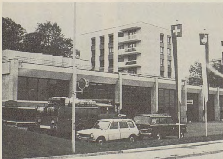
Die neue Feuerwehrezentrale an der Granges-Paccot-Strasse
