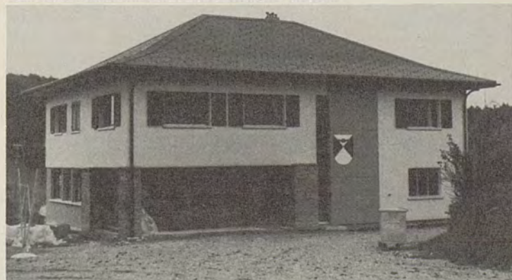
Das neue Gemeindehaus konnte bezogen werden.
