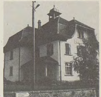
Der Schulhausweg neben dem Schulhaus (Bild) wurde erschlossen
