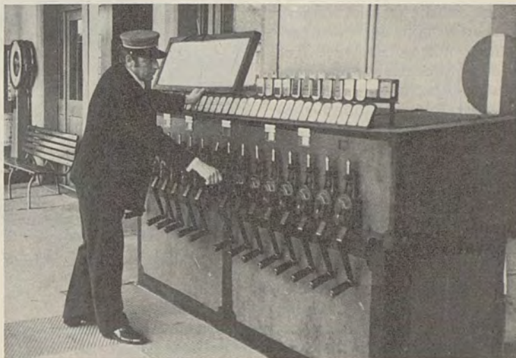
Hans Hachen am Befehlsstellwerk des Bahnhofes Kerzers. Von hier aus gibt er Fahrstrassen für die Bahn frei, doch stellt er von hier aus weder Weichen noch Signale, sondern übermittelt damit die Befehle ins Stellwerk.
