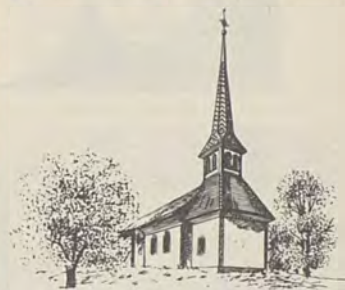
Die Marienkirche im Dürrenberg soll renoviert werden.
