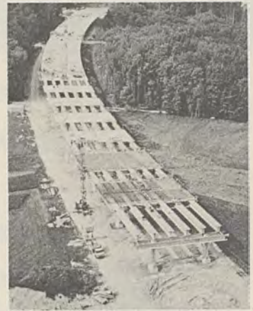
Autobahnviadukt der N 1 bei Galmiz
