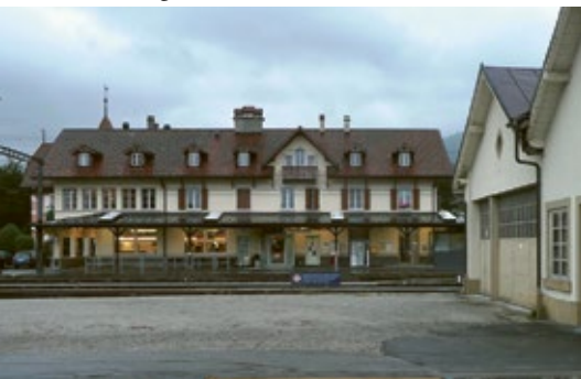
La gare de Châtel-saint-Denis.
