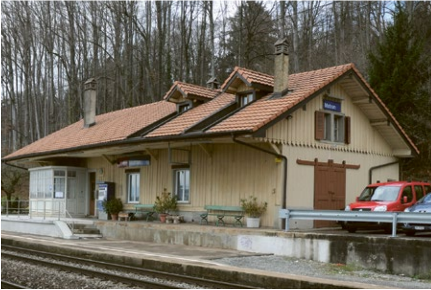
Gare de Matran: l'ensemble des bâtiments de la gare existent encore, une rareté.
