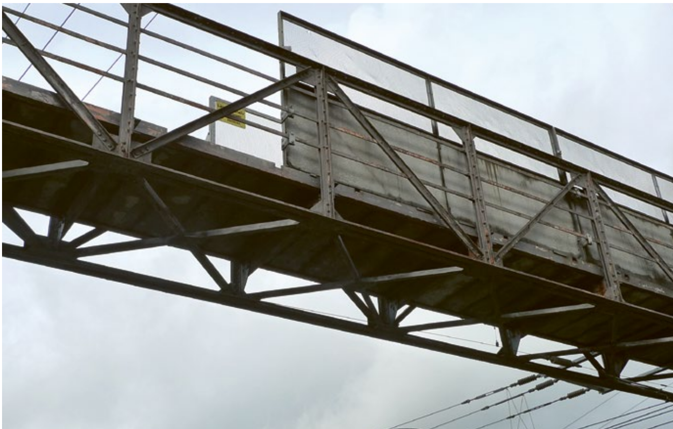
La passerelle centenaire de Chiètres: détail de la structure métallique.
