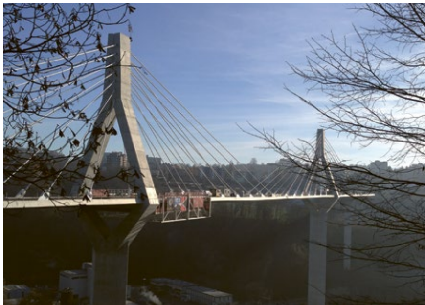
La jonction au milieu du pont de la Poya tout juste réalisée.
