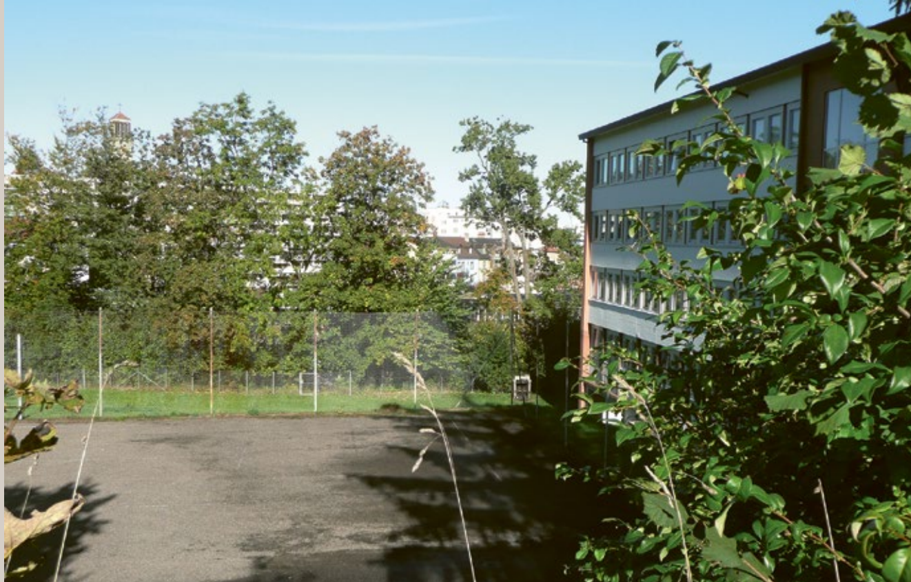
Une partie du parc de l'Africanum, avec en contrebas la forêt et à droite le bâtiment voué à la démolition.
