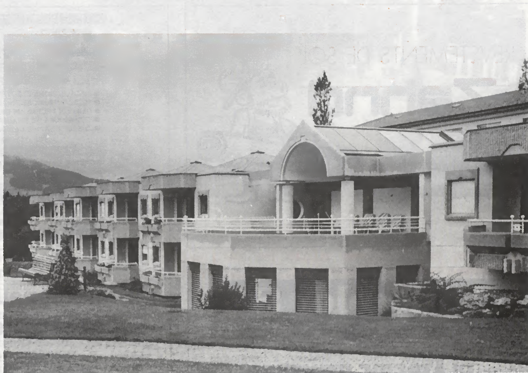
Le home du Châtelet, façade nord et façade sud.
