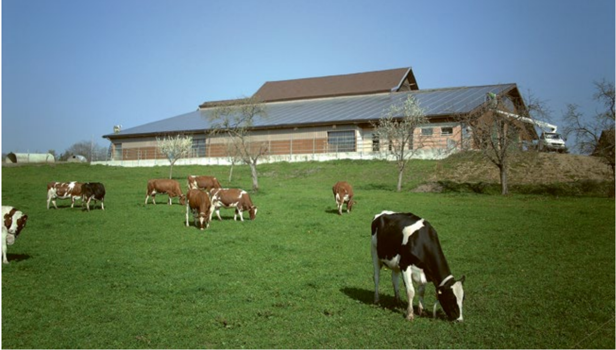
Ferme de Barberêche dont le toit est équipé d'une centrale solaire. Bauernhof in Bärfischen mit einer Solaranlage auf dem Dach.
