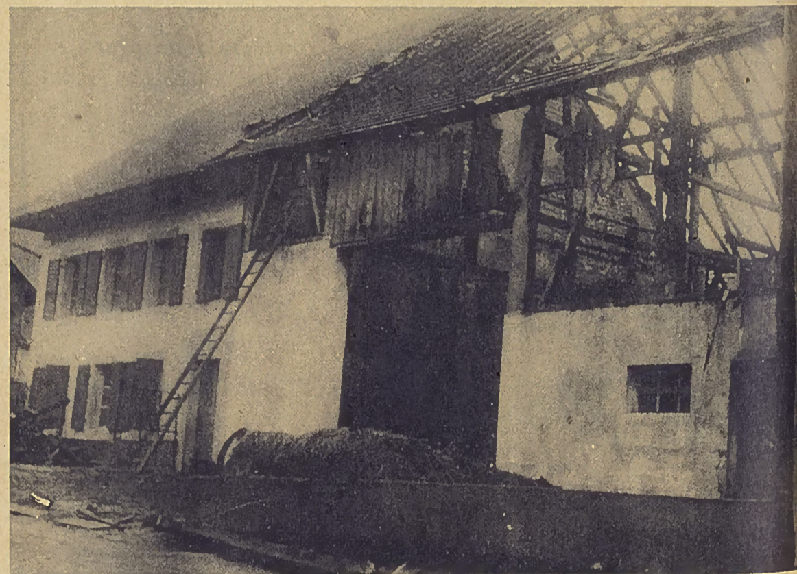
Deux vues du bâtiment sinistré, dont le rural est complètement détruit.
