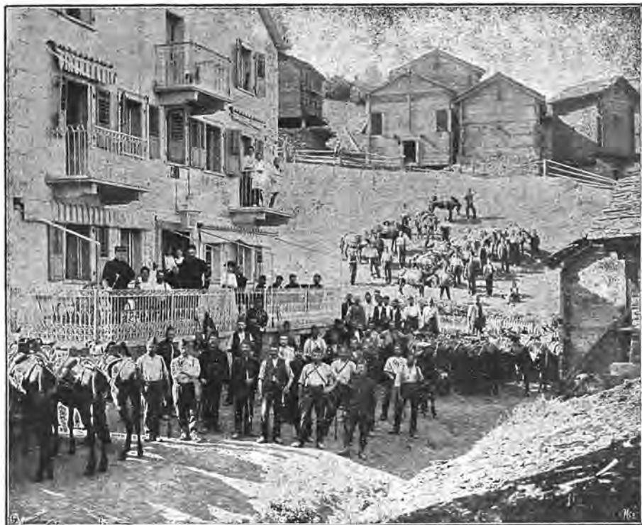
Rast des Zuges bei der Herbeischaffung des Materials zum Kanalbau in Wisperterminen.
