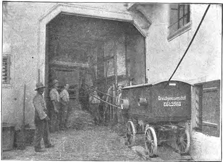
Abbildung 11. Dreschmaschinenbetrieb mit großem, fahrbaren Motor der Maschinenfabrik Derlikon.
