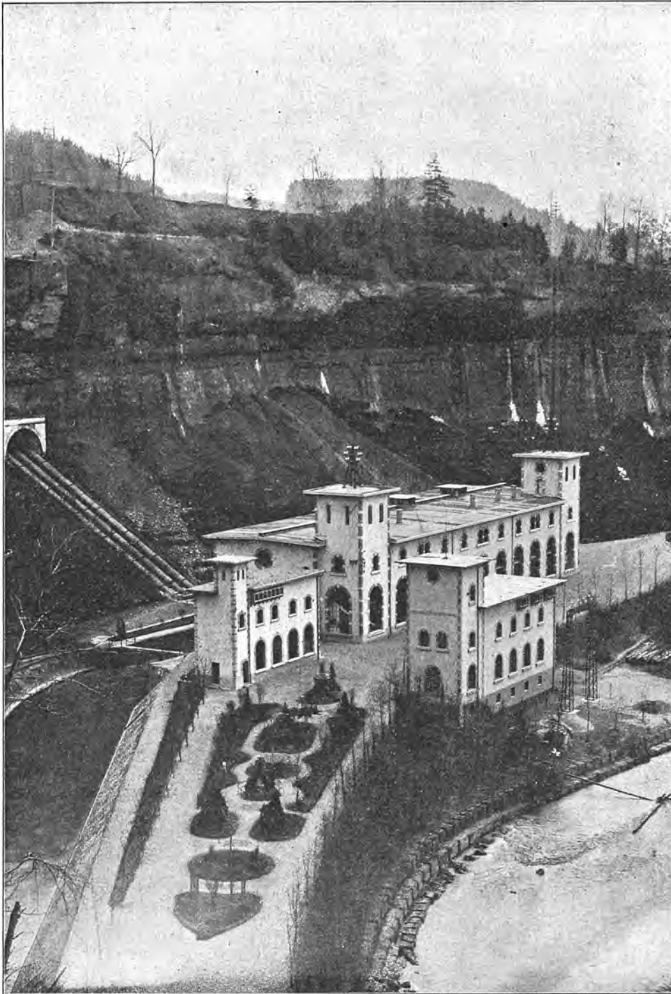
Abbildung 5. Elektrizitätswerk Altenrhf. Das größte Elektrizitätswerk des Kantons Freiburg.
