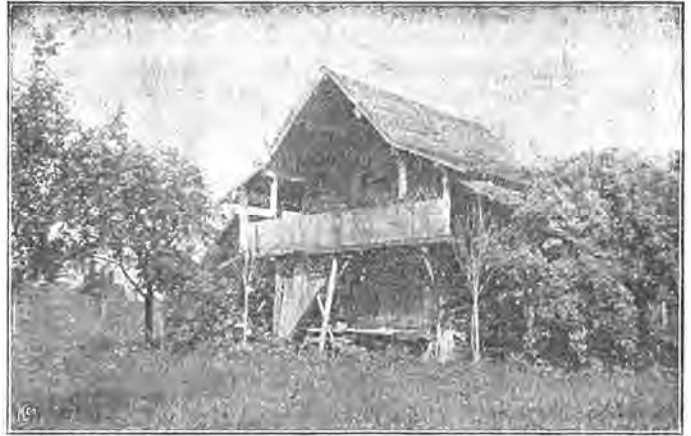
Kornspeicher in Käsch, Dürdingen, Freiburg. Phot. von Prof. Stöcklin.
