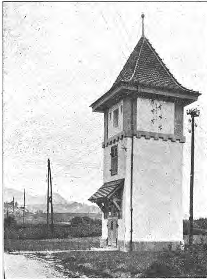
Abbildung 7. Gefällige Bauart eines Transformatorgebäudes.
