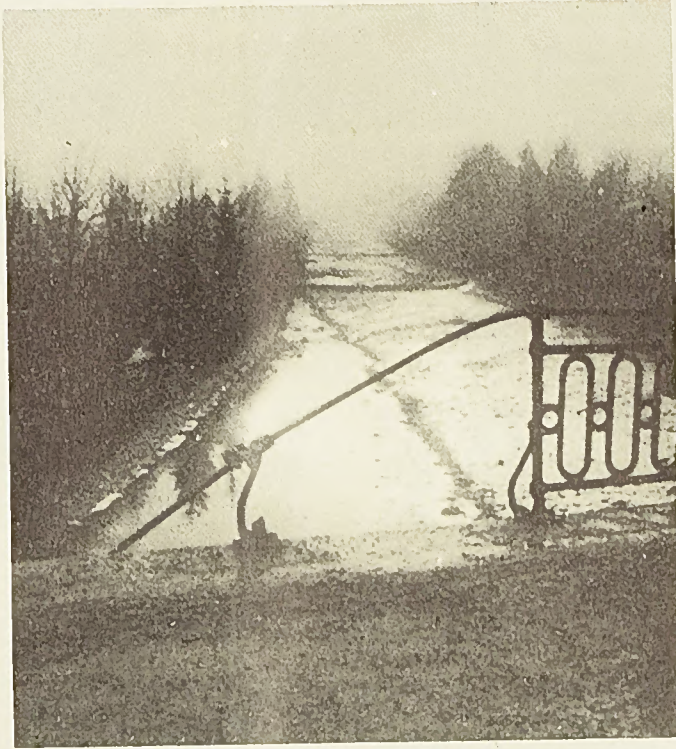
Ce paysage aurait pu être la dernière vision de Mlle Etienne. Au premier plan, la barrière brisée du pont qui fut arrachée sur onze mètres.
