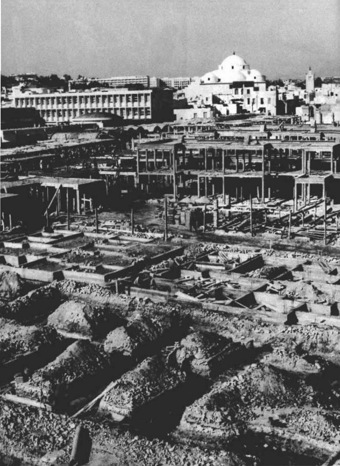
Tunis: chantier Hafcia (photo: Abdelmajid Nefzi)
