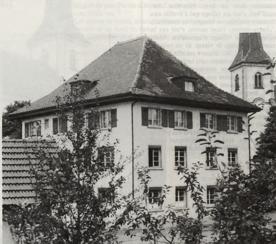
Le bâtiment scolaire qui abrite quatre classes et l'administration communale.
