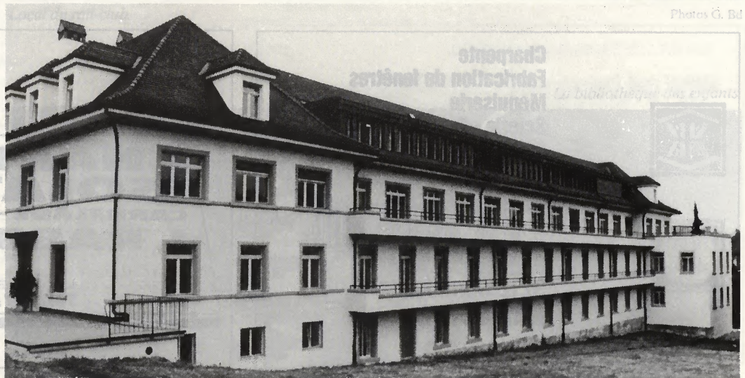
Le bâtiment rénové vu du côté Criblet.
