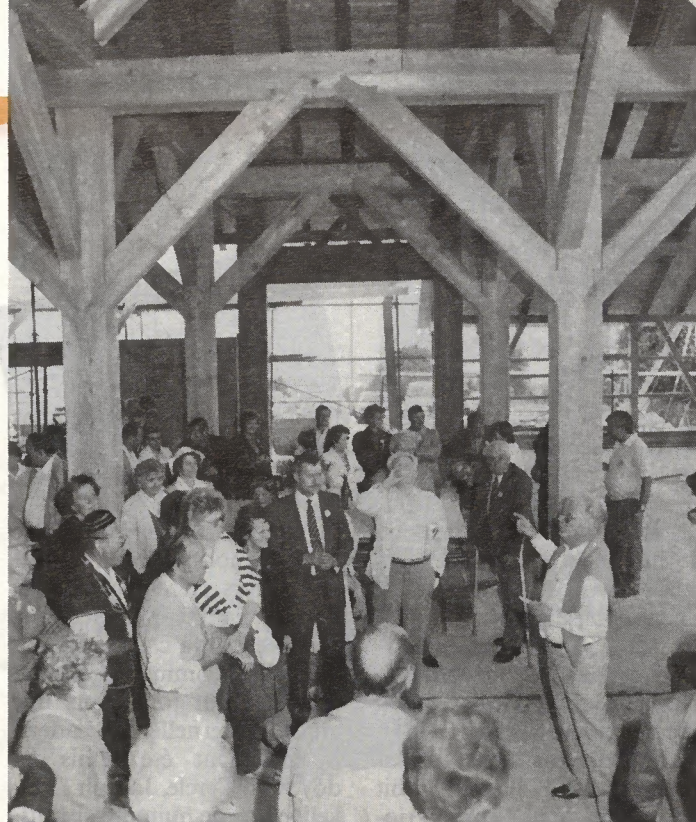
Visite du chantier des Colombettes complétée d'un exposé clair et précis de M. Louis Fragnière, que nous voyons sur la droite de notre photo.
