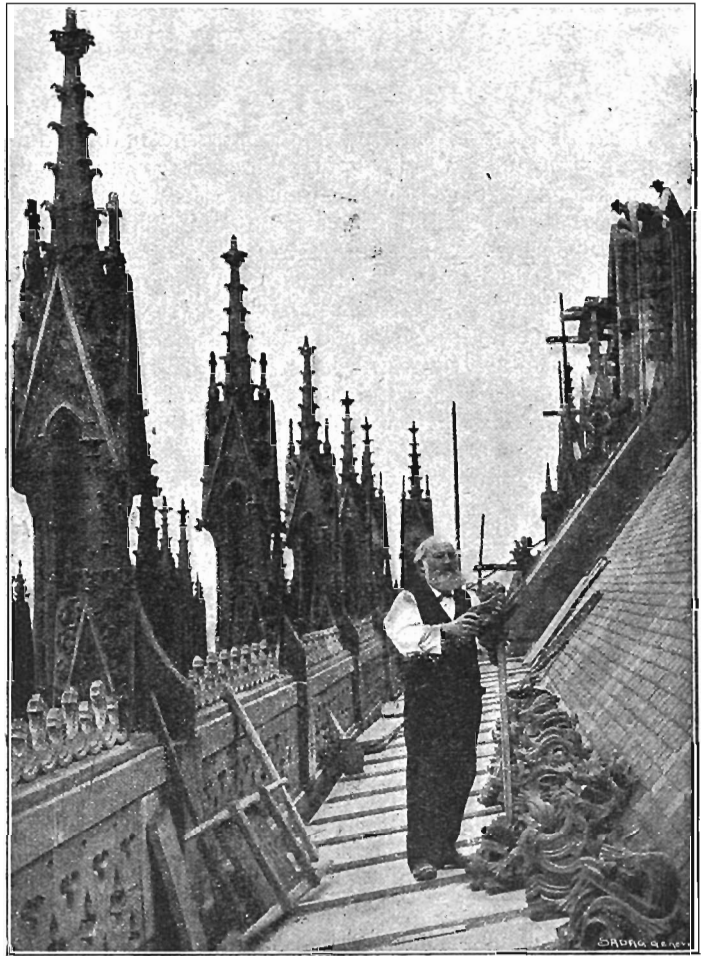
W. Ritter an der Arbeit auf dem Dache der Kirche in Neuenburg.
