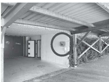
Bei der Zivilschutzanlage in Grossguschelmuth 7
