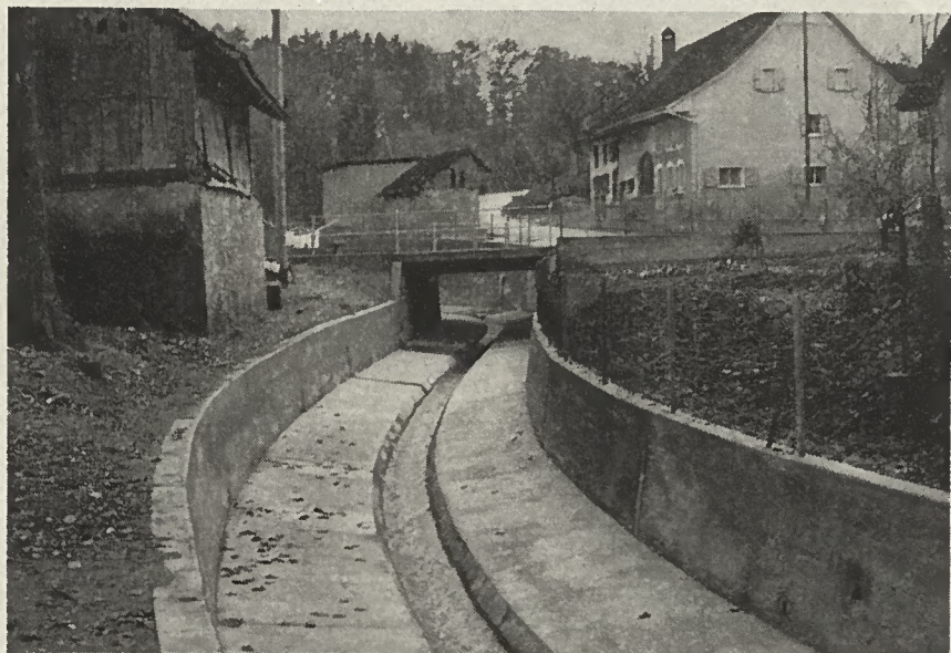
Travaux d'endiguement récemment effectués entre Delley et Portalban.
