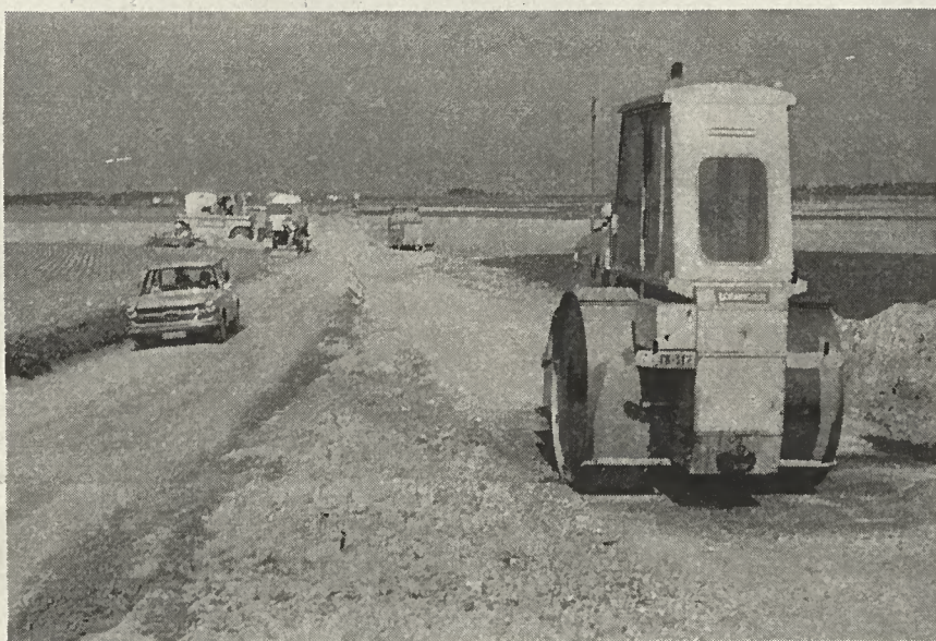
D'importants travaux ont lieu actuellement dans la campagne slaviacoise pour le remaniement parcellaire de la région.
