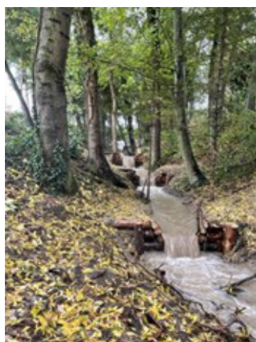
Remise en état du Ruisseau de Gruon
