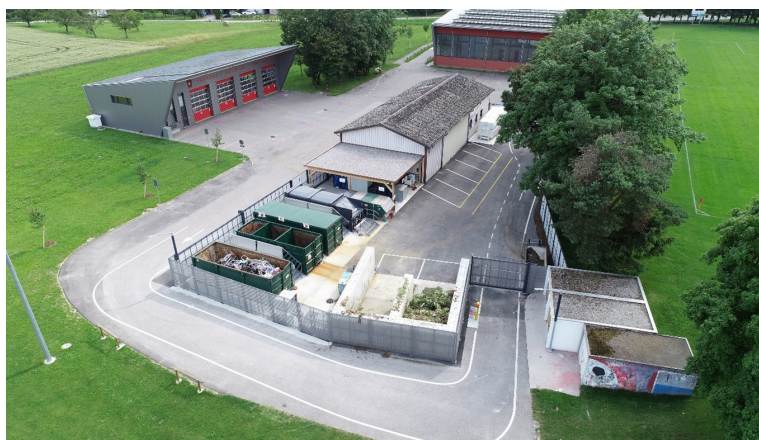
Restructuration de la déchetterie
