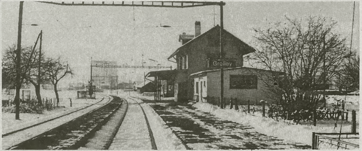
La gare de Grolley. Au fond, les silos de la Brasserie Cardinal
