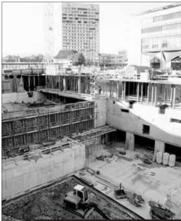
Le grand chantier du Centre-ville.
