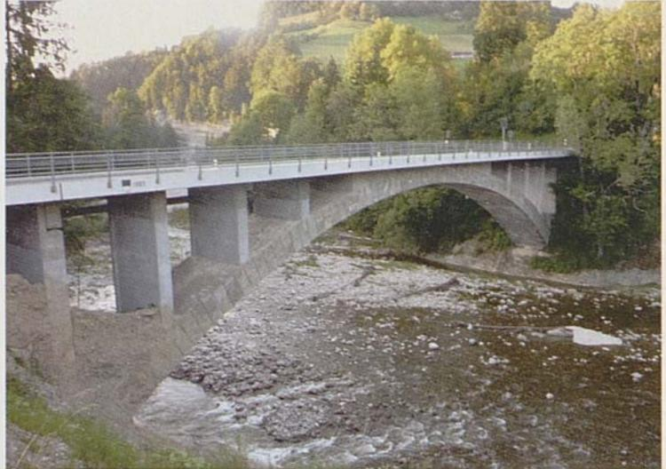
*Die Guggersbachbrücke führt bei Zumholz über die Sense ins Parkgebiet. Sie ist architekturgeschichtlich von grosser Bedeutung, wurde sie doch bereits 1906 erbaut und war damals mit 51 m Spannweite die grösste Eisenbetonbrücke der Schweiz.*
