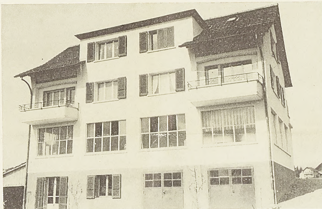
Le vaste atelier occupe tout le rez-de-chaussée.
