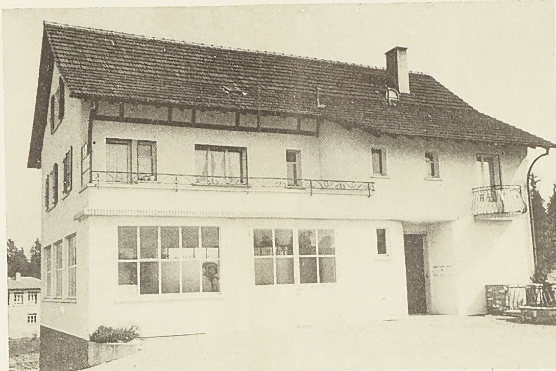
La nouvelle construction, avec atelier, vue du côté ouest.
