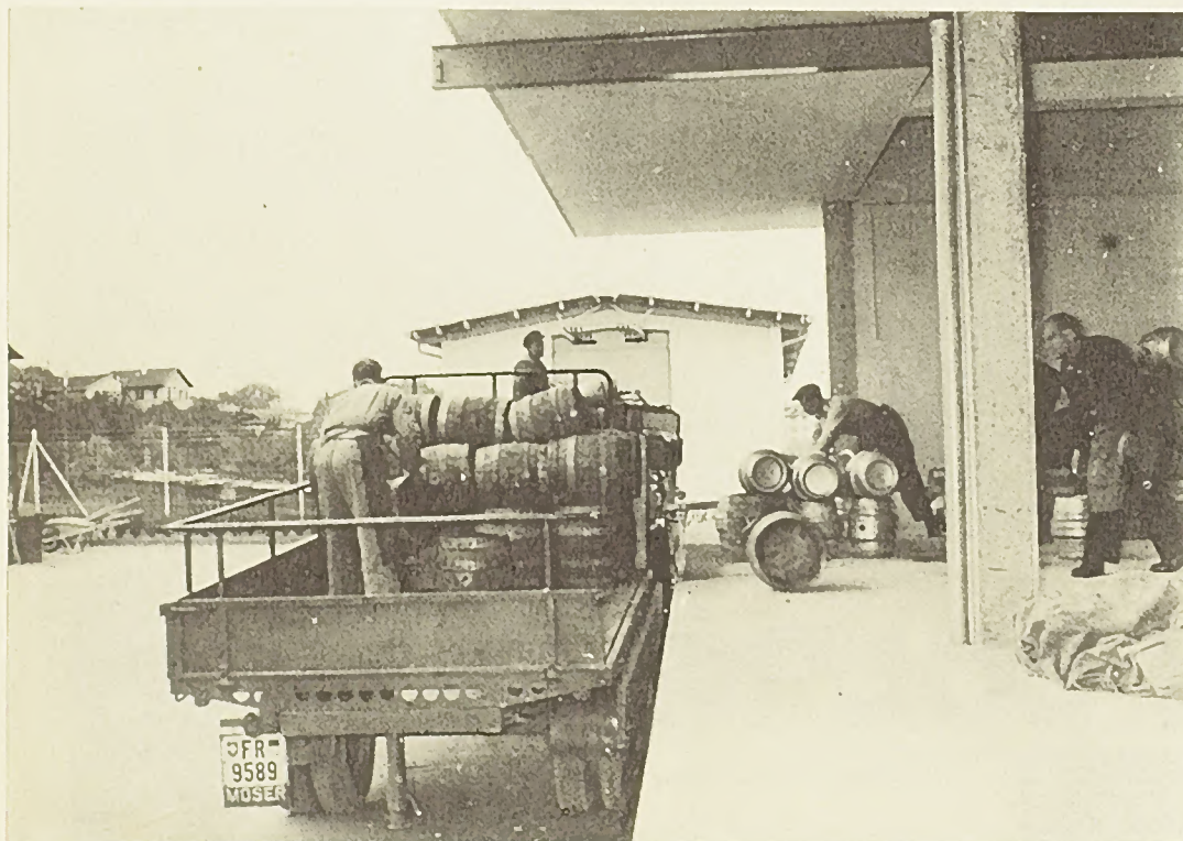
Le chargement d'un camion depuis le quai du nouveau dépôt.
