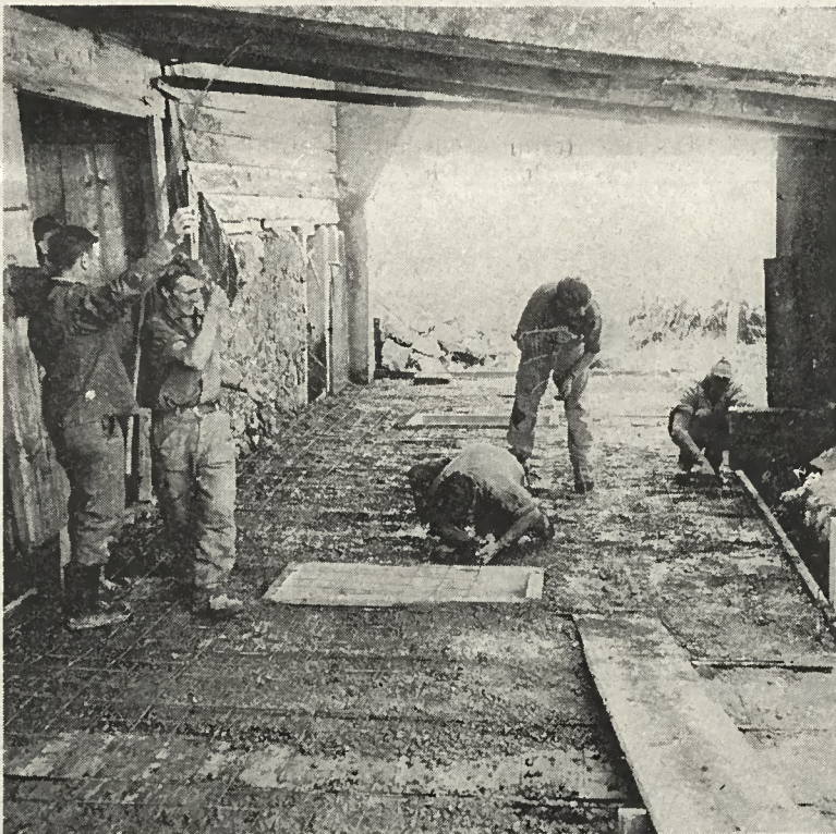
Assainissement d'étable et construction d'une dalle bétonnée à Montsofz.
