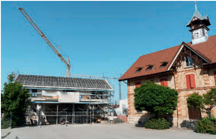
Stand der Sanierung des neuen Schulhauses im Juni 2019.
