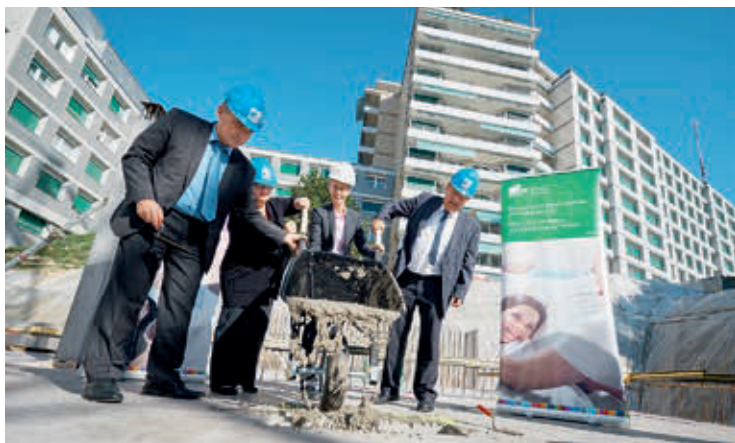
Im September 2018 findet der Spatenstich für das neue Gebäude für den Medizin-Master statt. Bild Archiv Lib./Charles Ellena
