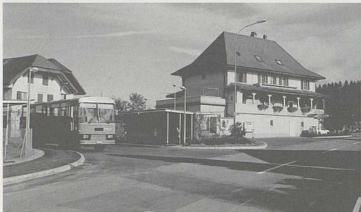
Die neue Bushaltestelle wurde bis im Juni zusammen mit den Umgebungsarbeiten fertig erstellt.
