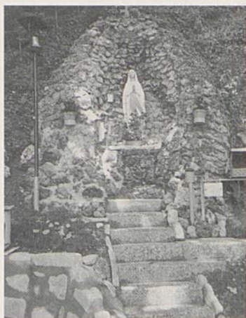
Die vom Sturm Lothar beschädigte Lourdesgrotte wurde mit viel Engagement wieder hergestellt.
