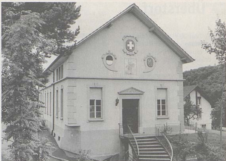
Die Fassaden des Pfarreizentrums wurden erneuert.
