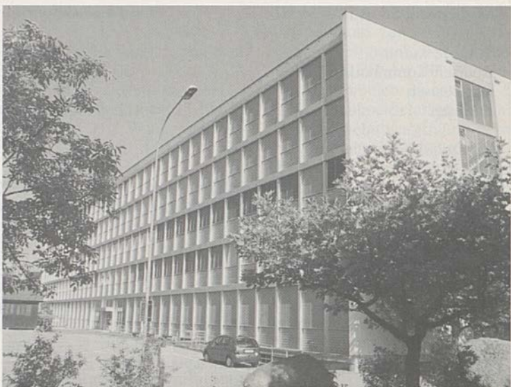
Gebäude der HSW an der Museumsstrasse im Pérollesquartier in Freiburg
