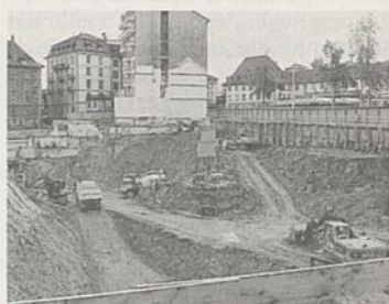
Eine gewaltige Baugrube prägt zur Zeit das Stadtzentrum Freiburgs.
