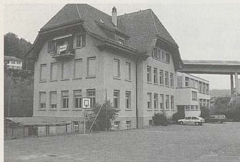
Aus dem ehemaligen Schulhaus der Freien öffentlichen Schule Flamatt wurde ein Begegnungszentrum der Kirchgemeinde. Doch dient das Haus auch andern Institutionen wie der Spitex.
