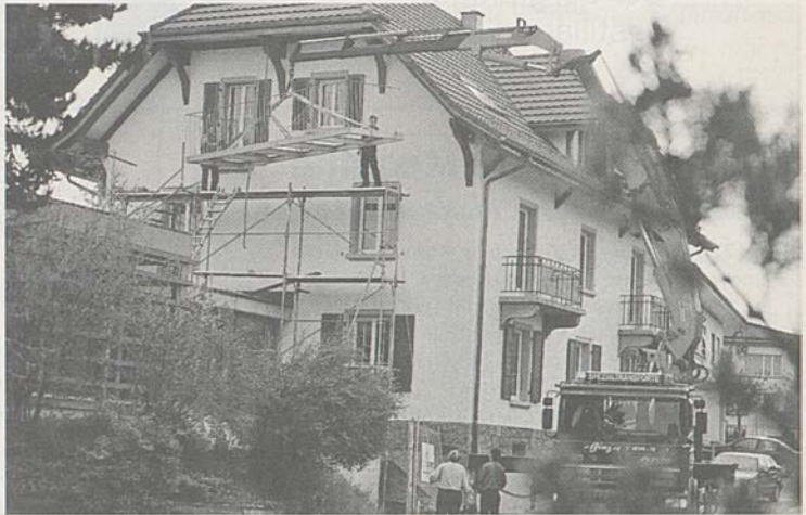
Letzte Arbeiten am erweiterten und renovierten Gemeindehaus.
