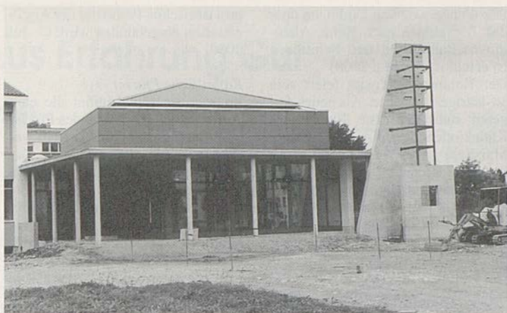
Seit Oktober 1999 ist das neue Reformierte Zentrum Hasli im Bau.
