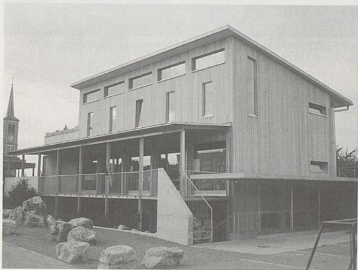
In diesem Neubau sind die Bibliothek, die Ludothek und die Spielgruppe untergebracht.
