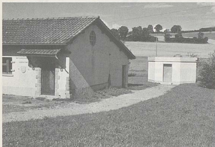
Ohne Wasser kein Leben! Der neue Filterbrunnen im Silberrad (rechts im Bild) schöpft rund 2000 Liter pro Minute. Er wurde im Herbst 1999 in Betrieb genommen.
