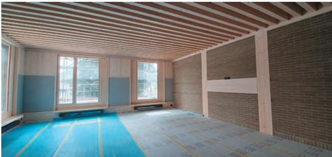
A l'intérieur, les plafonds et les revêtements de sol sont en grande partie terminés. L'ossature et les cloisons en bois, quant à elles, disparaissent petit à petit derrière les panneaux de finition. Les revêtements en panneaux 3-plis donnent une ambiance chaleureuse.
