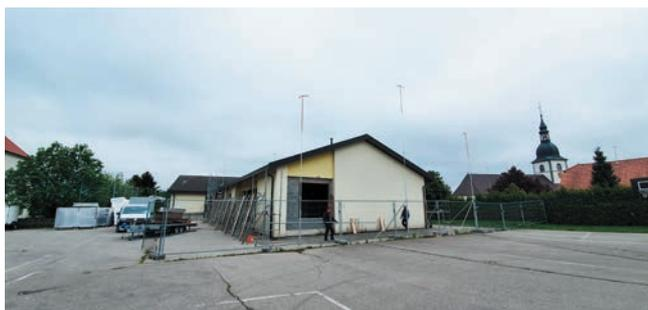
Pour rappel, le projet d'agrandissement du bâtiment E prévoit la démolition complète du bâtiment existant jusqu'au niveau de la dalle sur sous-sol. Un nouveau volume sera construit sur deux étages. Les parois, les planchers et la toiture seront composés d'une nouvelle ossature en bois. Le concept respecte les mêmes critères que ceux énoncés dans le projet du bâtiment A, à savoir une organisation pertinente des espaces, une qualité architecturale, une mise en valeur du centre du
