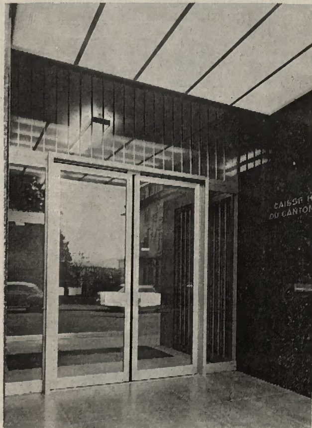
Porte d'entrée d'un établissement bancaire de Fribourg. Réalisation des Ateliers Gougain. (Photo Hans Schmid, Fribourg.)
