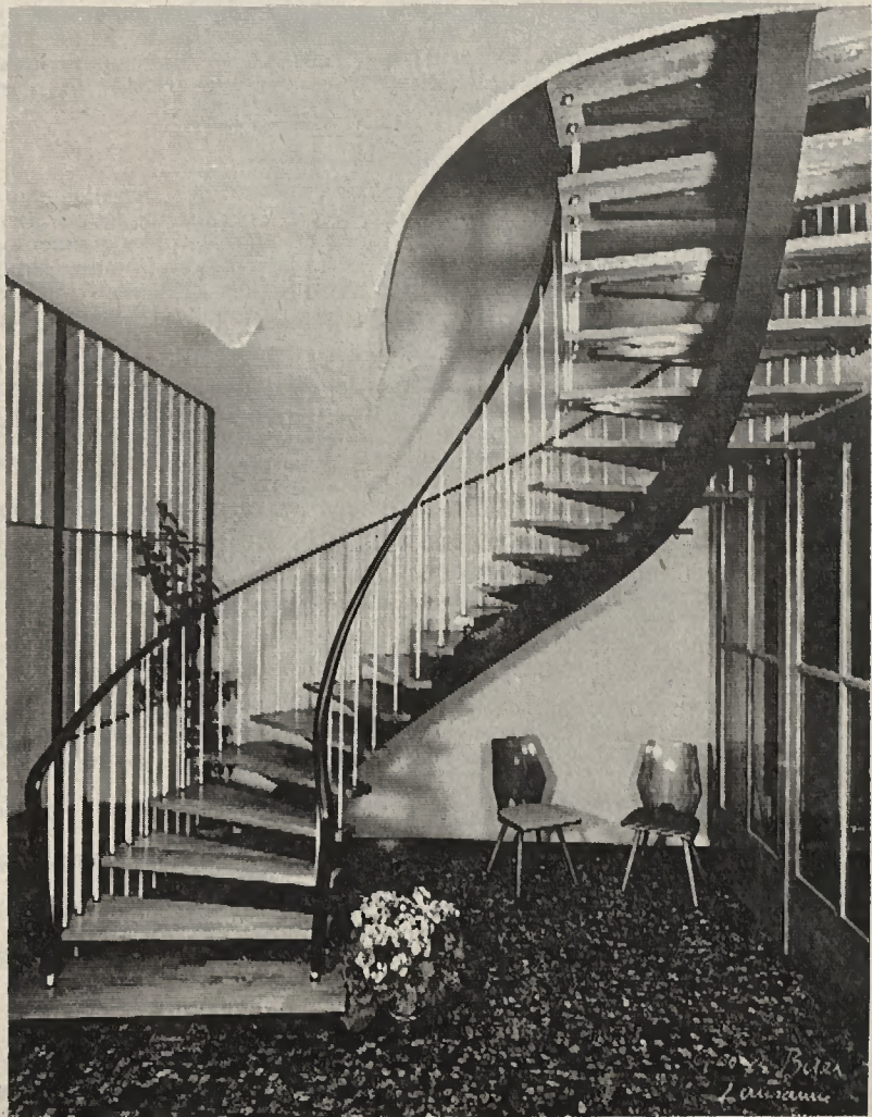
Escalier métallique à trois rayons sur une seule âme, à l'Institut des Hautes-Études à Lausanne. Exécution des Ateliers Brandt à Bulle
