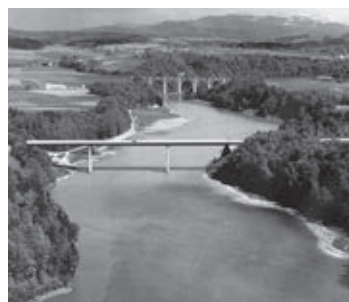
Magdalenenbrücke der A12 über die Saane bei Freiburg, Entwurf und Ausführung Ateliers de Constructions Mécaniques SA in Vevey, Beratung Ing. Jean Dubas und Ing. Hans Hauri in Zürich, 1963 bis 1969. Im Hintergrund die Grandfey-Viadukt der SBB bei Freiburg. Die beiden Brücken überqueren die Saane, die durch den Schiffenstaudamm gestaut wird.
