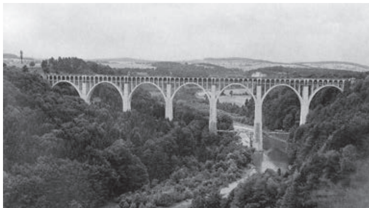
Grandfey-Viadukt, Betonbrücke System Melan über die Saane bei Freiburg, Entwurf und Projektleitung Ing. Adolf Bühler mit der Sektion Brückenbau der SBB, Berater Robert Maillart und Co. in Genf, Ausführung Simonett & Co. und Prader & Co. in Zürich, 1925 bis 1927.
