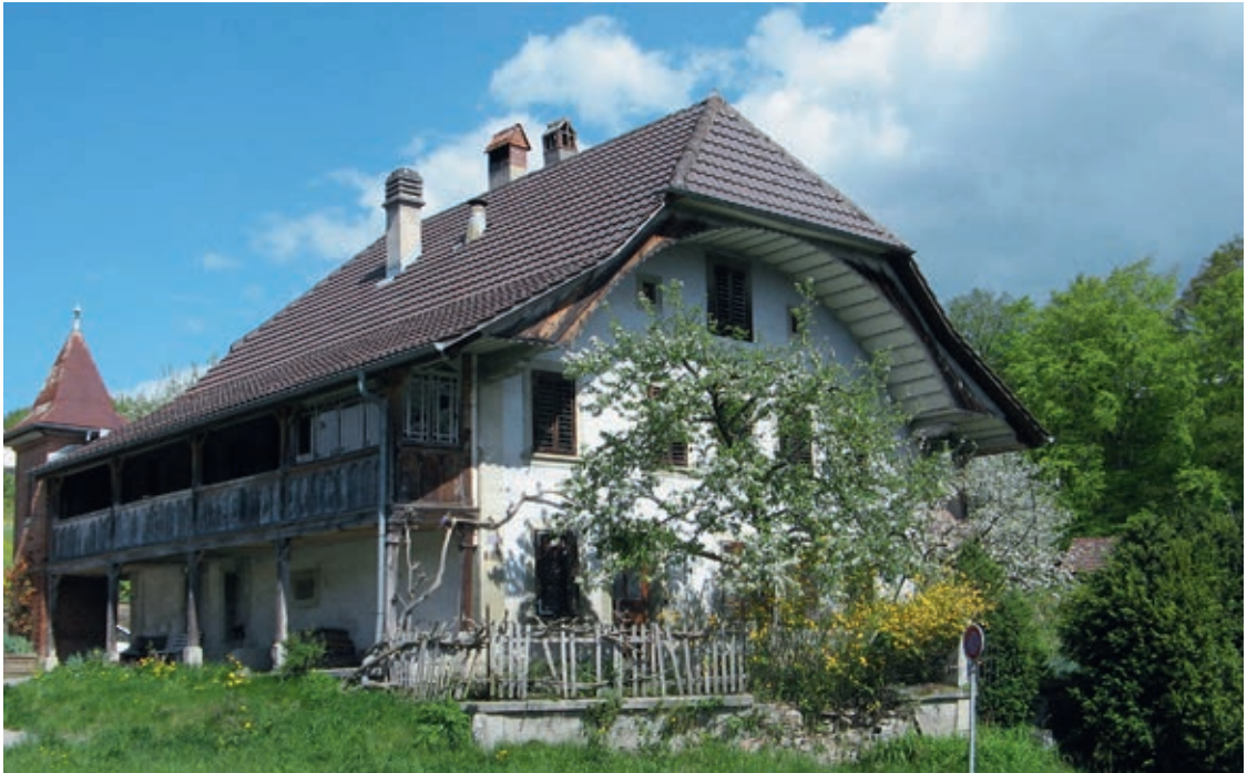
Das ehemalige Wohnhaus mit Arztpraxis von Jean Scherer in Courtepin.
