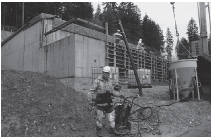
Bau des neuen Reservoirs «Allmet».
