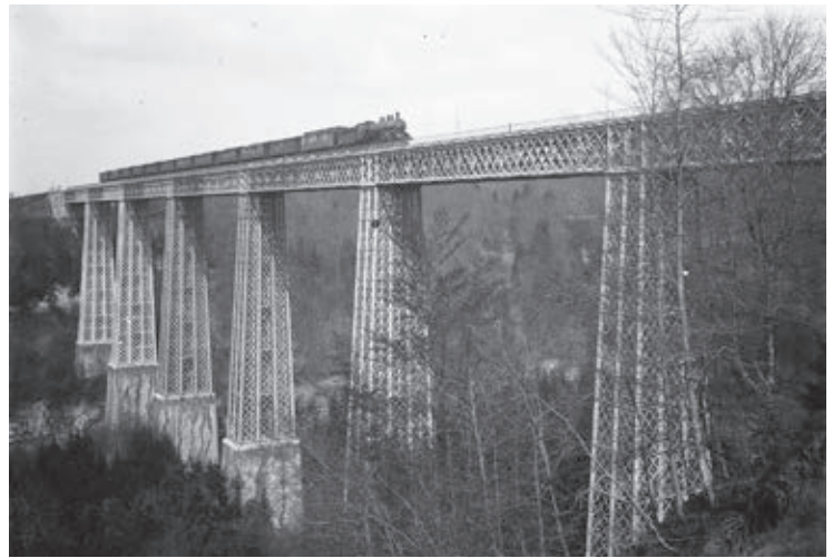
Grandfey-Viadukt, Eisengitterbrücke über die Saane bei Freiburg. Entwurf einer Expertengruppe der Ing. Nördling, Etzel, Durbach und Jacquemin, Projekt und Ausführung Ing. Mattieu und die Usines du Creusol/France, 1857 bis 1862. Der Viadukt wurde teilweise in den Neubau von 1927 integriert.
