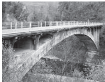
Guggersbachbrücke bei Zumholz, ein Pionierwerk aus Betonsteinen und armiertem Beton des Ingenieurs Jules Jaeger, 1906. Im Bild der Zustand vor der Erneuerung: Stützen und Fahrbahn wurden 1986 stark verändert.
