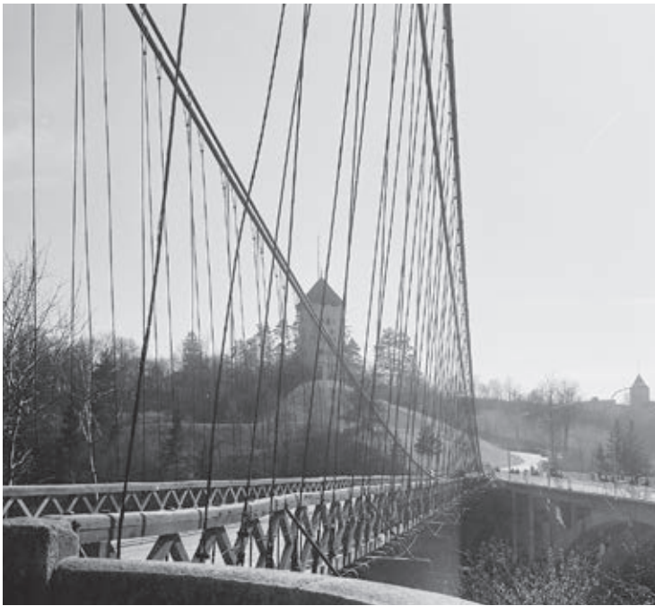
Galternbrücke, Drahtseilbrücke über den Galternbach, Entwurf und Projektleitung Ing. Joseph Chaley, 1838 bis 1840. Nach dem Bau der neuen Galternbrücke (rechts im Bild) wurde sie 1960 abgebrochen.
