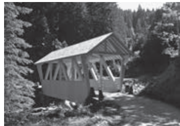
Die neue Höllbachbrücke. Bild zvg
