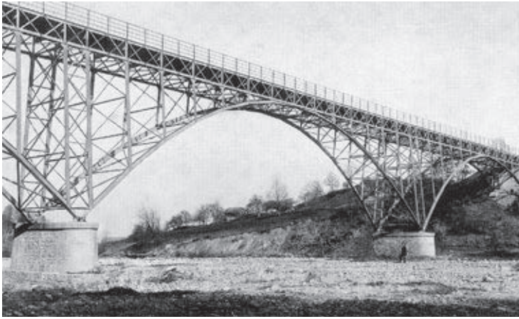
Eisengitterbrücke über die Aegergera bei St. Silvester, Projekt und Ausführung Ingenieure Moritz Probst, Atelier Probst, Chappuis und Wolf in Nidau BE, 1887 bis 1888. Die Brücke wurde 1983 abgebrochen.
