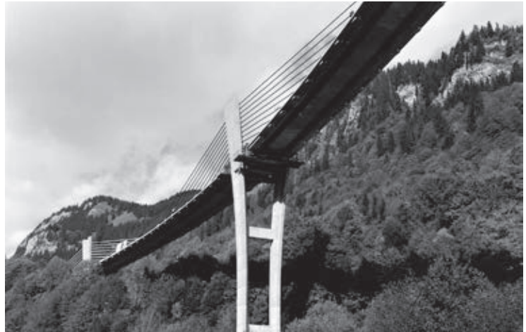
Sunnibergbrücke im Prättigau bei Klosters, entwickelt aus dem Konzept für eine Poyabrücke in Freiburg. Entwurf des Ingenieurs Christian Menn. 1996 bis 1998.
