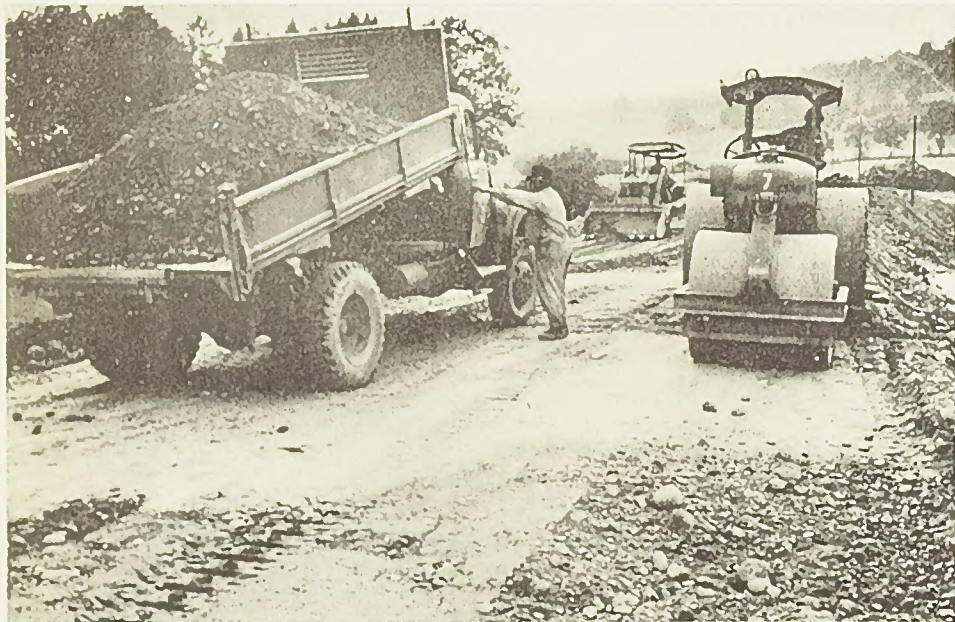
Cette vue prise sur le chantier de l'entreprise GRISONI-ZAUGG montre 3 opérations successives de la construction : Le camion déverse une nouvelle couche. Le bulldozer l'égalise et le rouleau compresseur lui donne la consistance.
