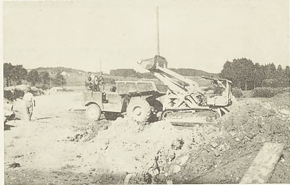
Chargement d'un dumpers par un traxcavator (lot GRISONI-ZAUGG).
