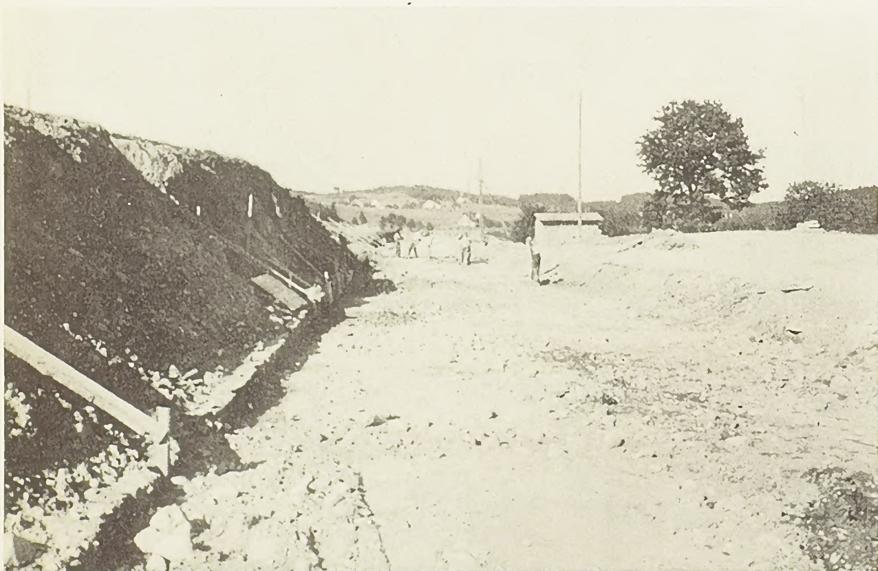
Vue partielle du vaste chantier des ROUTES S.A. ROMONT.
