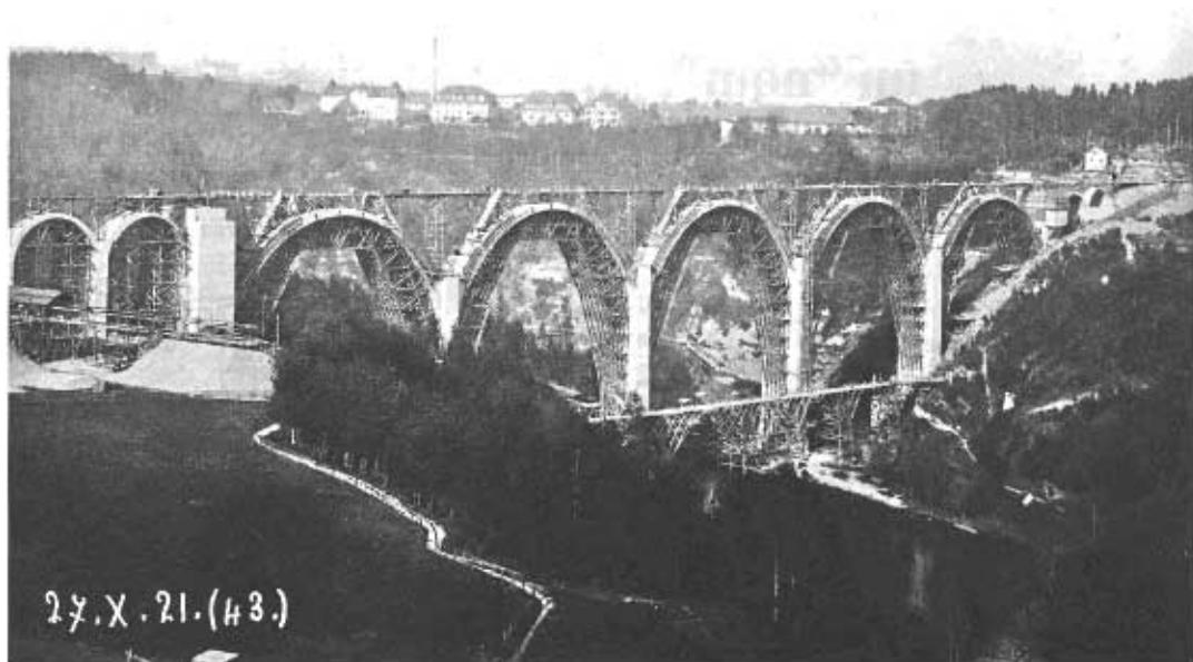
*En 1922, le pont de Péroles va désenclaver Marly. Ci-dessus, le pont de service est construit par Winckler et, ci-dessous, le pont terminé, l'entreprise s'installe au débouché du pont, à gauche de la photo.*
