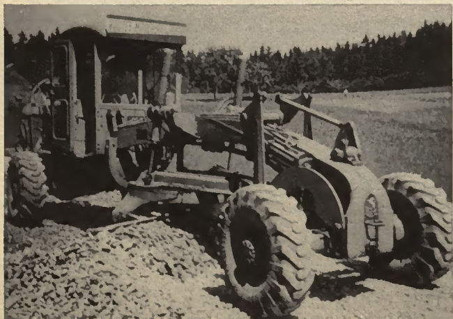
Niveleuse « GRADER » au travail.
