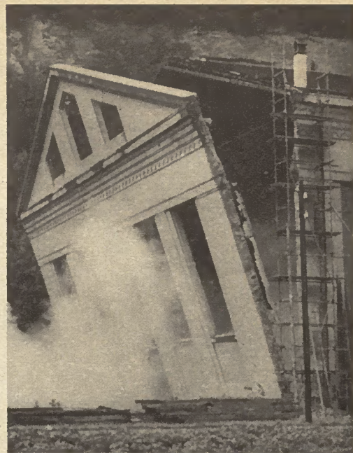
Renversement d'une façade à la mine (Usine thermique de la Malgrange)
