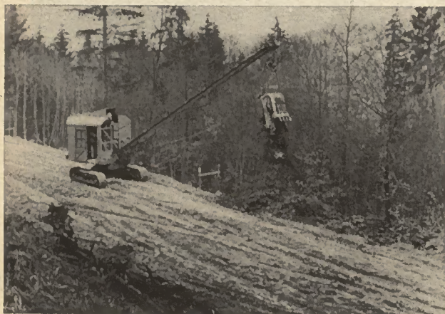
Pelle mécanique avec équipement dragline au travail.
