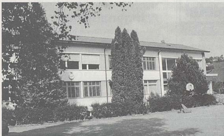
Dem fast 40jährigen Schulhaus steht eine Renovation und Erweiterung bevor.
