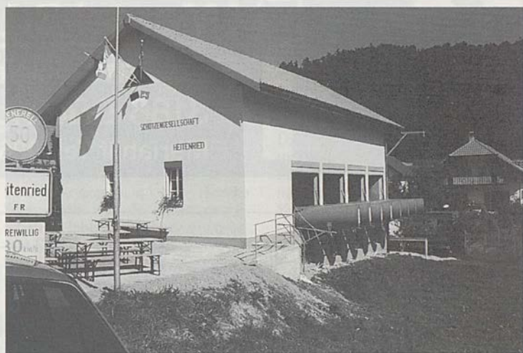
Das renovierte Schützenhaus mit den lärmdämmenden Schiesstunnels
