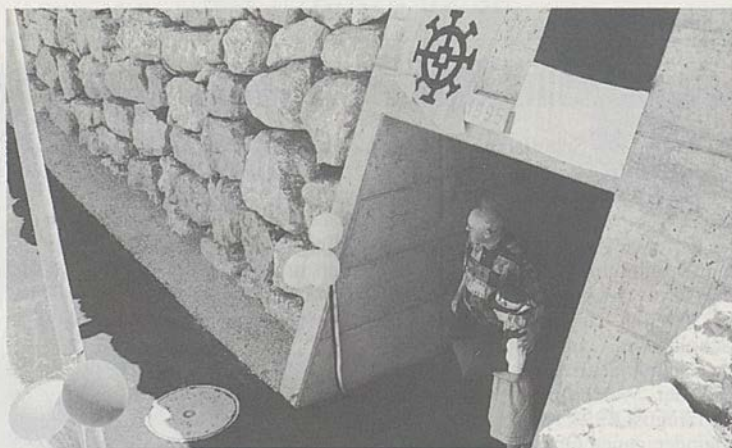
Die neue Fussgängerunterführung ermöglicht eine gefahrlose Verbindung zwischen dem Ober- und dem Unterdorf.
