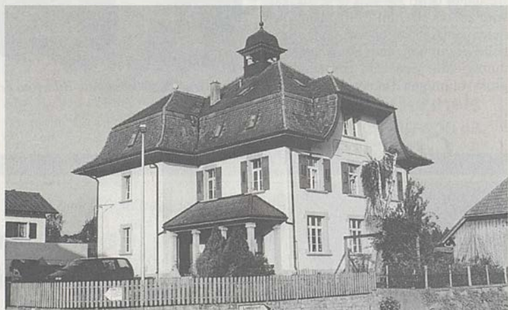
Das Schulhaus wird gegenwärtig umgebaut.
