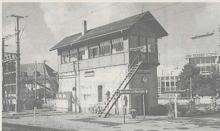
Das mechanische Stellwerk Kerzers wurde 100jährig.
