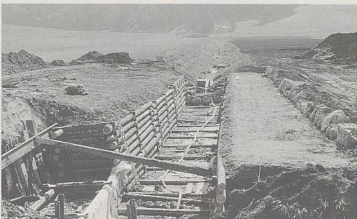
Die Sanierung der Taverna – hier eine Aufnahme der Arbeiten bei Rohrschreitet wie geplant voran.
