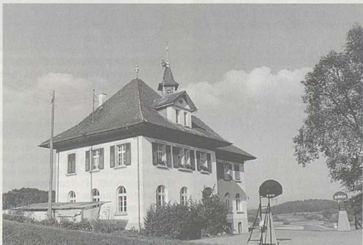
Im Schulhaus werden die Schulzimmer etappenweise renoviert.
