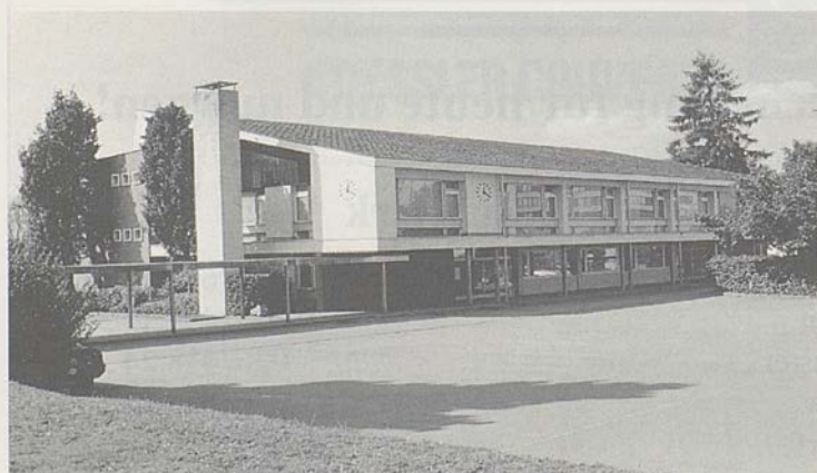
Nach dem bereits beschlossenen Ausbau der OS-Zentren Tafers und Plaffeien haben die Gemeinden auch dem Ausbau des OS-Zentrums in Düdingen zugestimmt. Zusätzlich wird das Zentrum in Düdingen mit einem grossen polyvalenten Saal erweitert.
