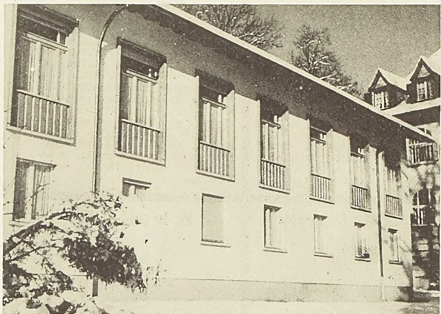
Le nouveau pavillon « Hertling », vu du côté sud.
