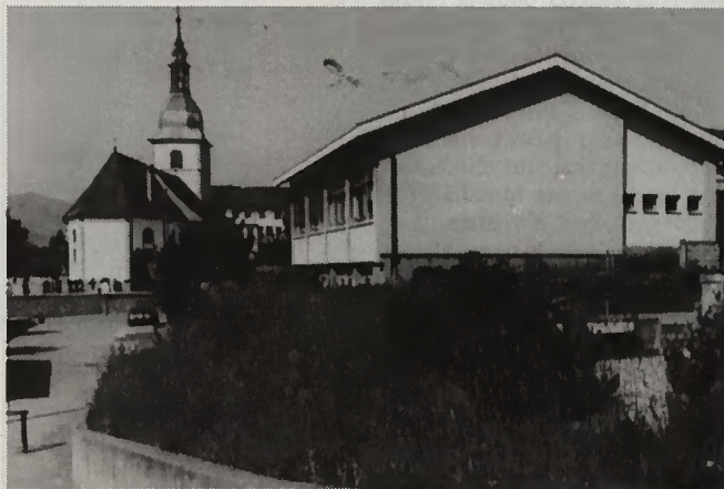
L'église paroissiale. A droite, au premier plan, le bâtiment scolaire.
