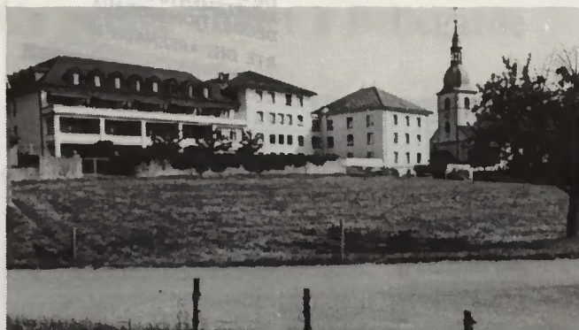
L'hôpital de district et l'église de Riaz.
