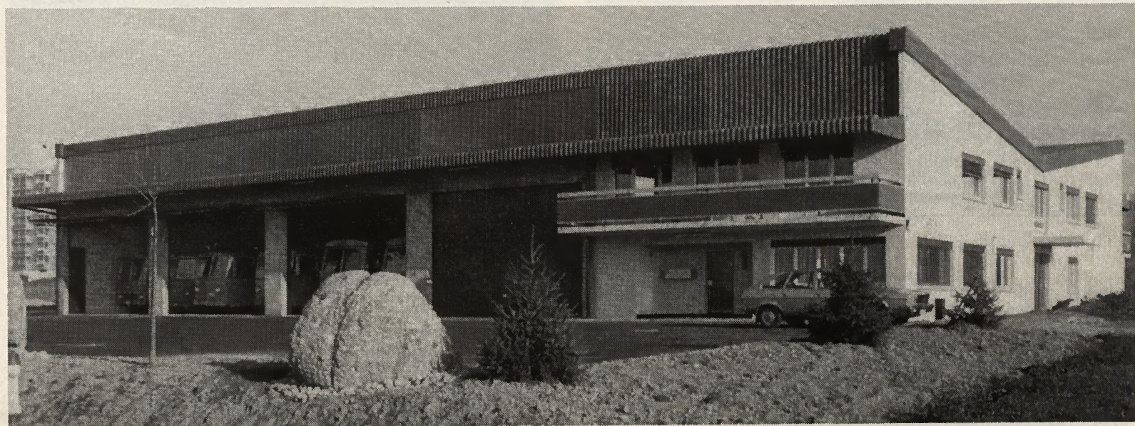
Le nouveau garage des GFM à Romont
