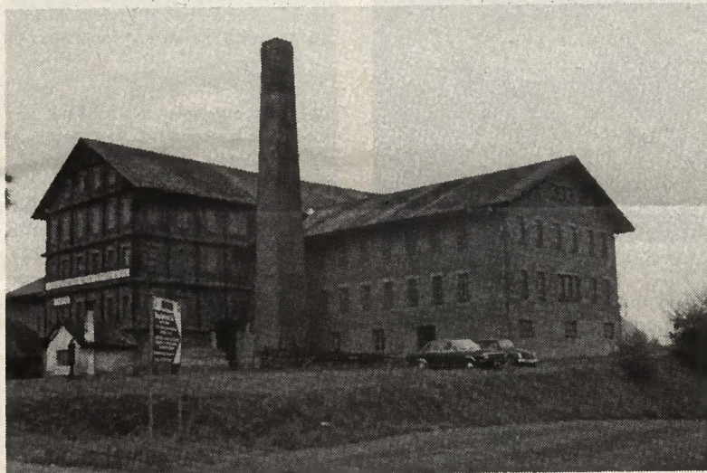
La tuilerie du Mouret avant la démolition de la cheminée
