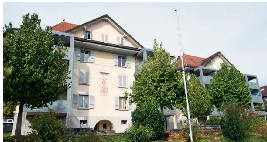
Deux des cinq maisons de la coopérative d'habitations La Fraternelle, vues depuis le chemin Charles-Meuwly. © Ville de Fribourg/V.B.
