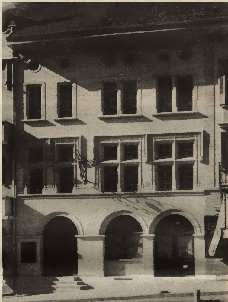
La façade actuelle. (Photo Geisel)
