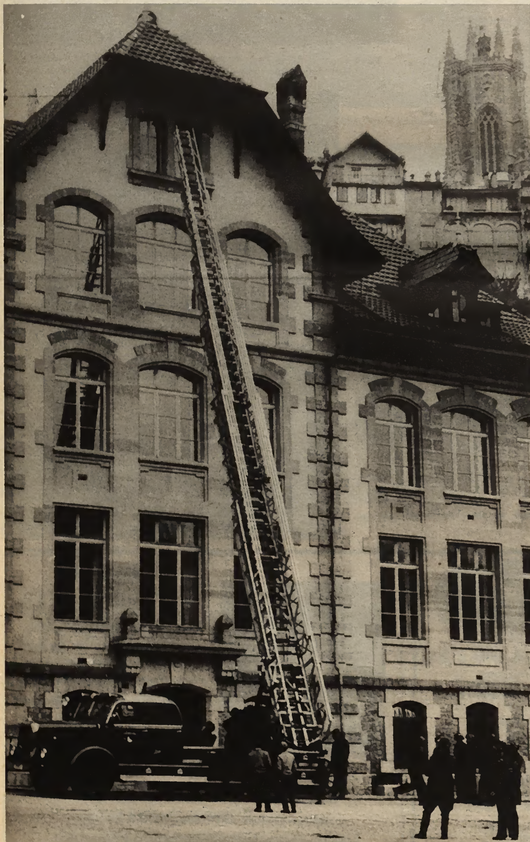
La grande échelle est dressée contre la façade de l'école de la Neuveville.
