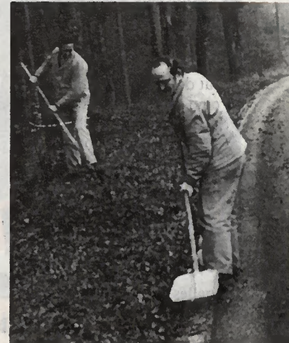
Le dégagement des canalisations, un travail important pour permettre l'écoulement de l'eau.
