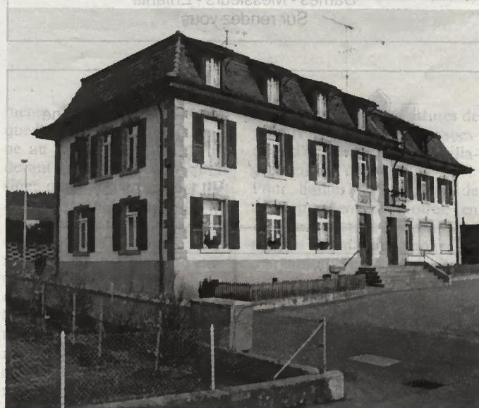
Le bâtiment scolaire.
