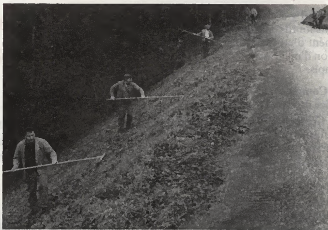
Le nettoyage des talus dans la région de Mannens.
