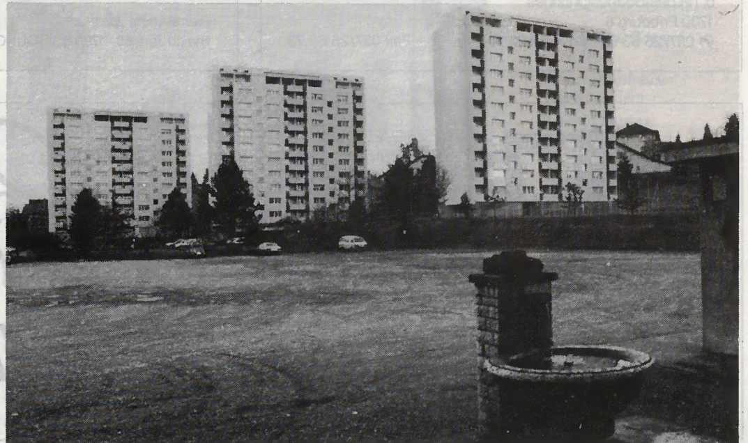
Trois tours qui dominent le quartier du Jura.
