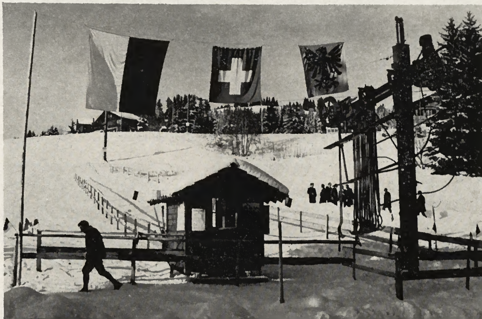
Le télésiège du lac des Joncs et ses installations. ▲
