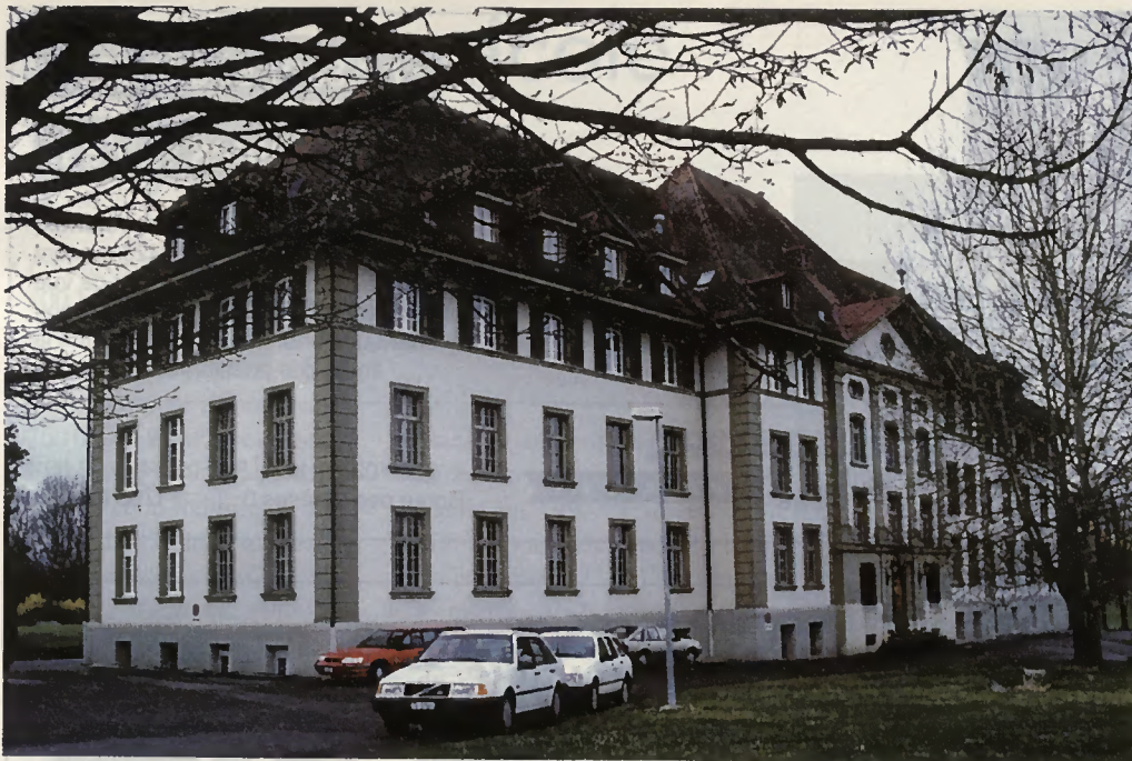
Le bâtiment de la formation agricole.
