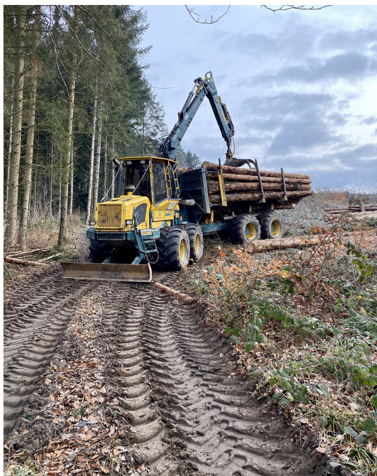
Coupe de conversion : Photos du chantier : Débardage au porteur
