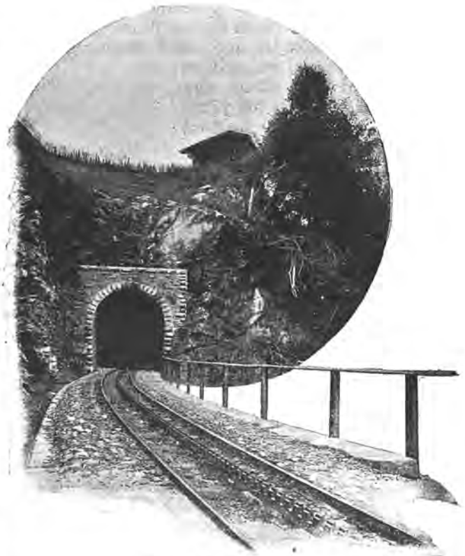
Der Tunnel bei Stalden.
