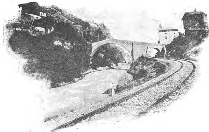
Die Neubrücke an der Visp-Zermattbahn.
