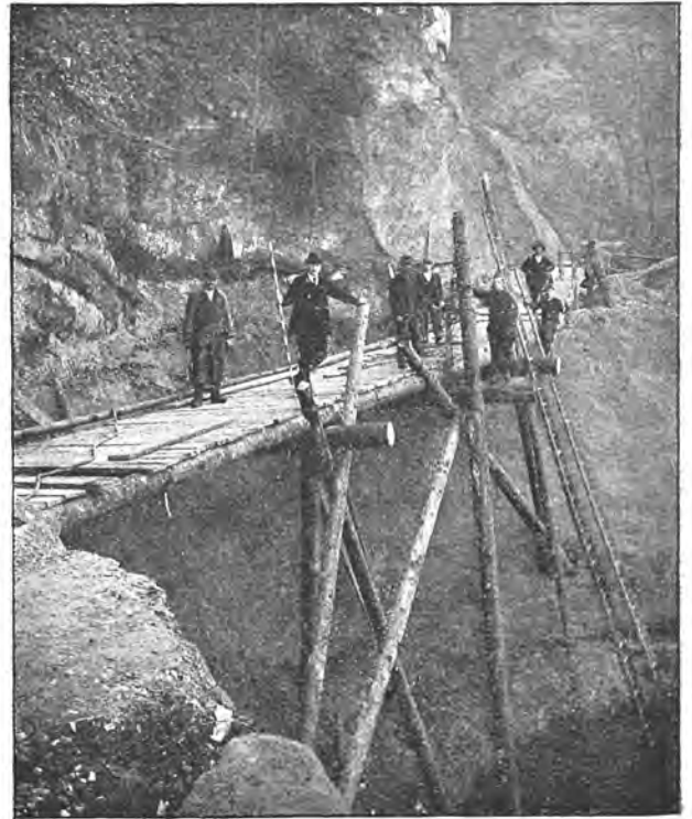
Notbrücke an der Schiffenenstraße, die v. Dübdingen nach Murten führt.
