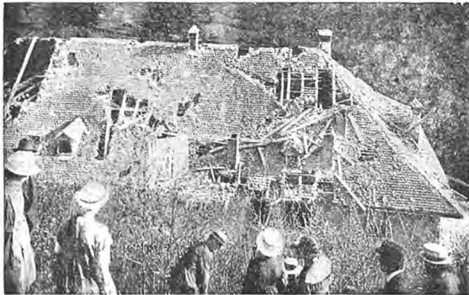
Das Haus Brohy unter der Galternbrücke mit arg verstümmeltem Dach.
