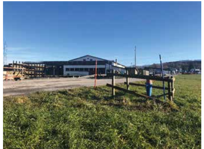
Une borne hydrante dans la zone industrielle de Granges
