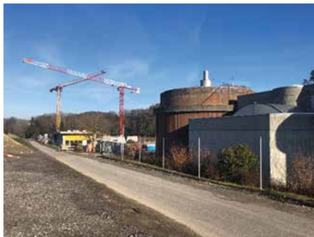
La station d'épuration de la Verna sur la commune d'Ecublens (Fribourg)
