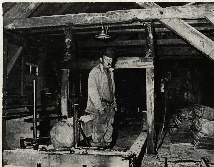
▼ Cette scierie a marché longtemps par la force de l'eau
