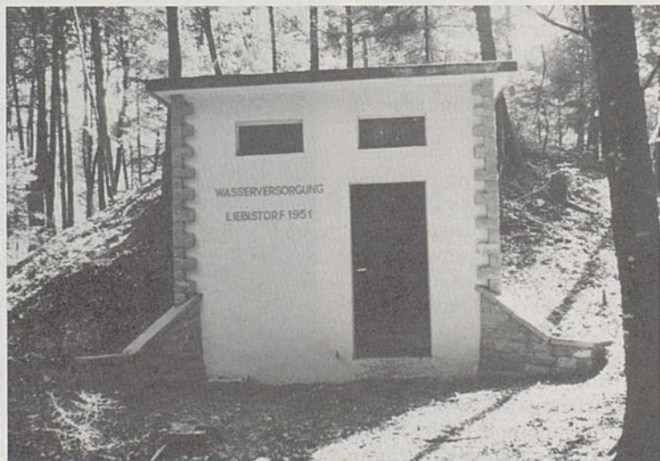
Das Trinkwasserreservoir wurde renoviert.
