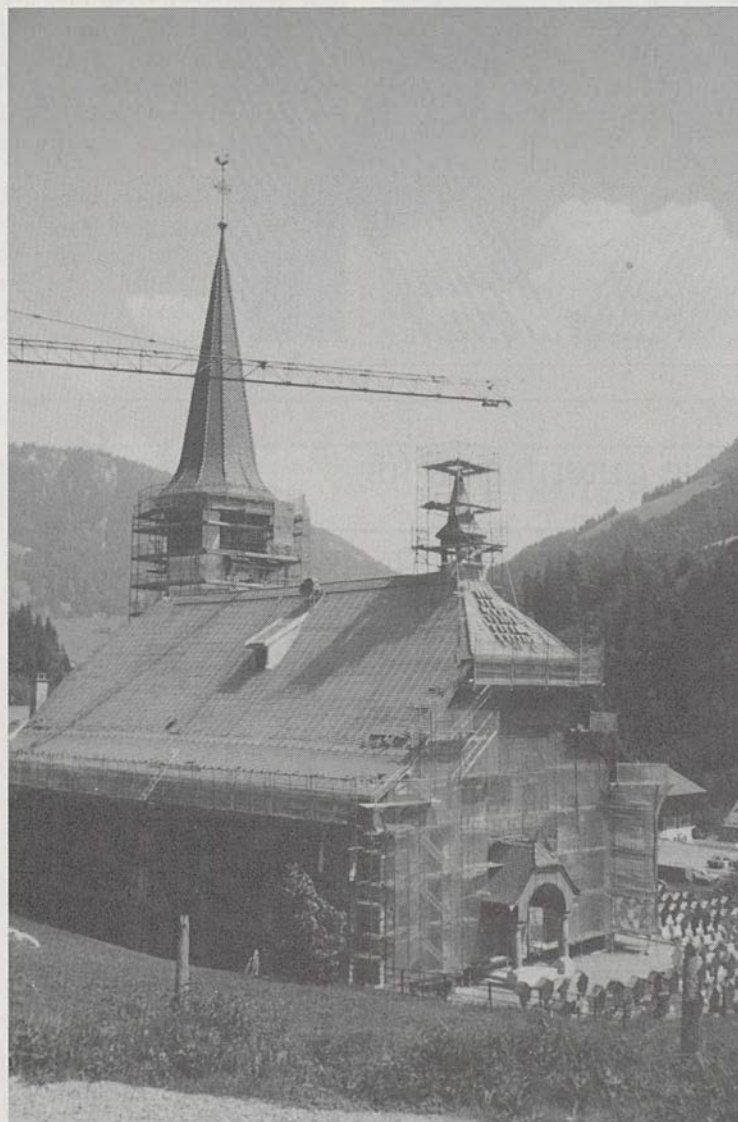
Die Kirche von Jaun wurde aussen renoviert und erhielt dabei auch ein neues Dach.
