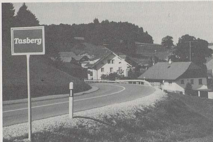
In Tasberg wird die Abwassersanierung vorgenommen.
