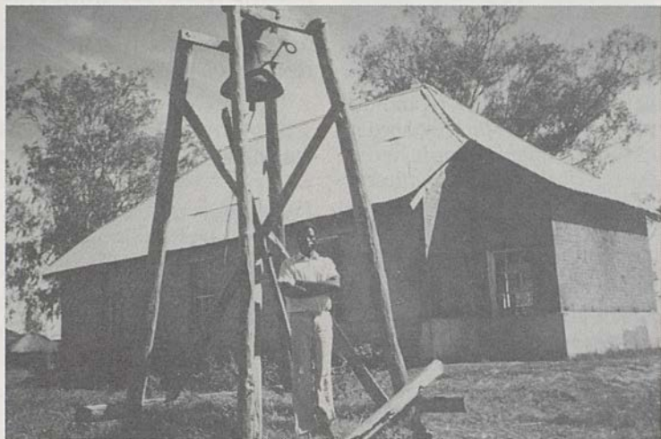
Der Glockenturm von Lumulunga in Sambia
