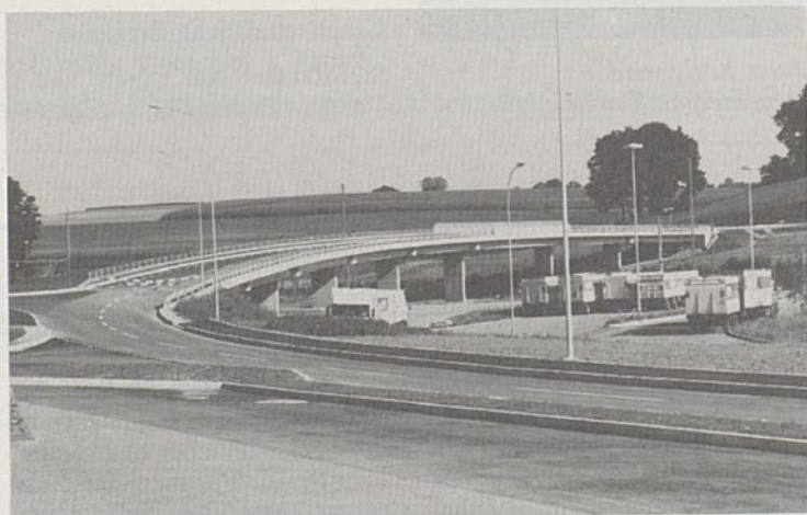
Die neue Eisenbahnüberführung und die neue Strasse von Schmitten nach Friesenheid konnten im Herbst 1989 dem Verkehr übergeben werden.
