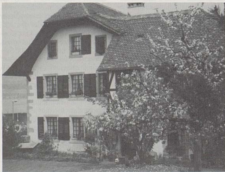
Das Chatoney-Haus, später Liechti-Haus genannt, stammt aus der zweiten Hälfte des 18. Jahrhunderts. Beim Grenzstreit von 1822 wurde es der Gemeinde Murten zugeschlagen.
