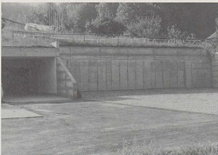
Die neue Zivilschutzanlage bietet 150 Personen Schutz (Foto Marcel Lehmann, Gruenenburg).
