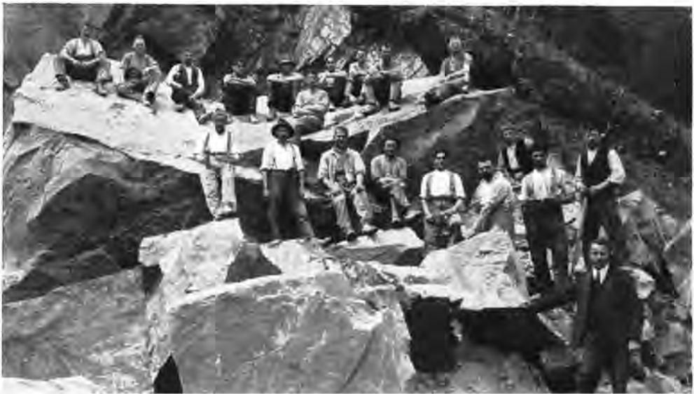
Felssturz beim Steinbruch im Zollhaus. Die Arbeiter haben sich auf den gewaltigen, herabgestürzten Blöcken aufgestellt.
