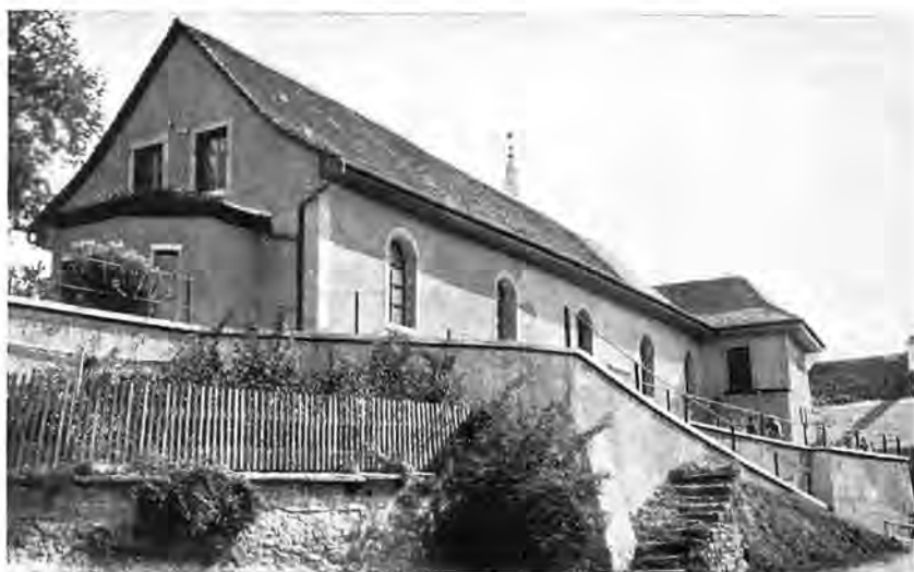
Die alte St. Michaelskirche von Heitenried, die nun dank der Bemühungen des eifrigen Herrn Pfarrers, Paul Perler, zu einem geräumigen Vereinshaus umgebaut wurde.
