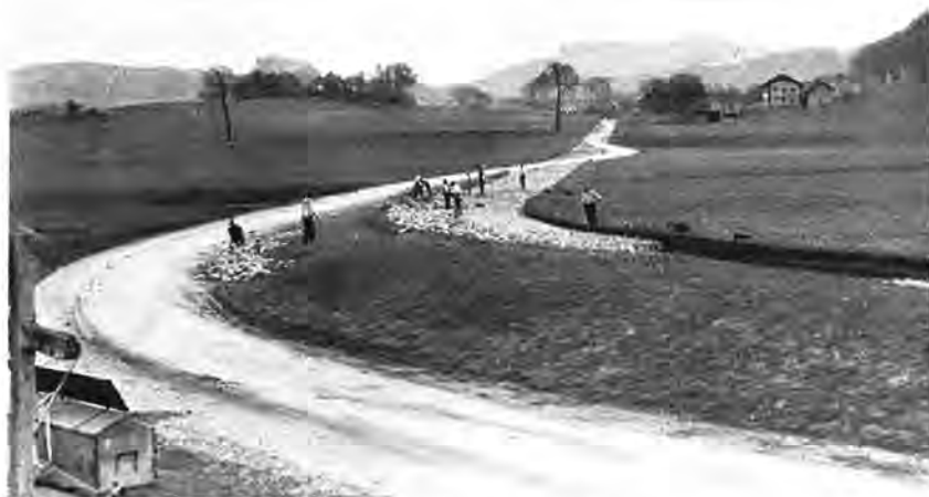
Die Mehrgerade von Tafers nach Freiburg.
