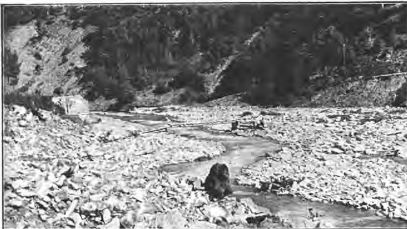
Teil des Senfetales, wo die Brücke weggeschwemmt wurde.
