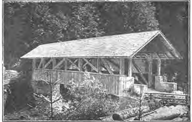
Die alte Hofländerbrücke, welche von der angeschwollenen Senfe ganz von ihrer Brüstung weggehoben wurde.
