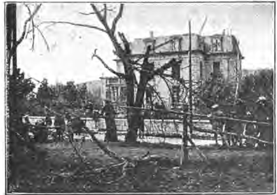
Das zerstörte Haus mit Umgebung am Tag nach dem Fliegerangriff auf Bruntrut.
