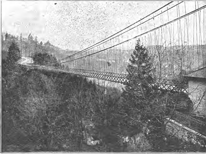
Galternbrücke vom rechten Ufer aus.
