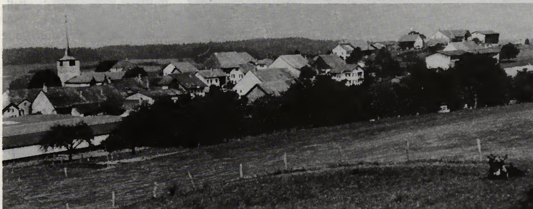
Murist: un village construit autour de son église.
