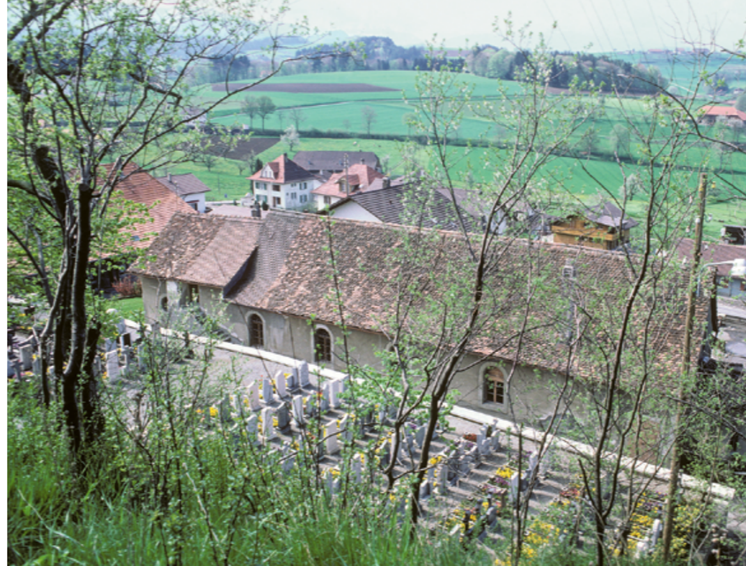
Fig. 41 L'église de Heitenried désaffectée vue depuis le nord avant la restauration des années 1980, avec l'emplacement du clocher supprimé en 1914, bien visible en toiture.
