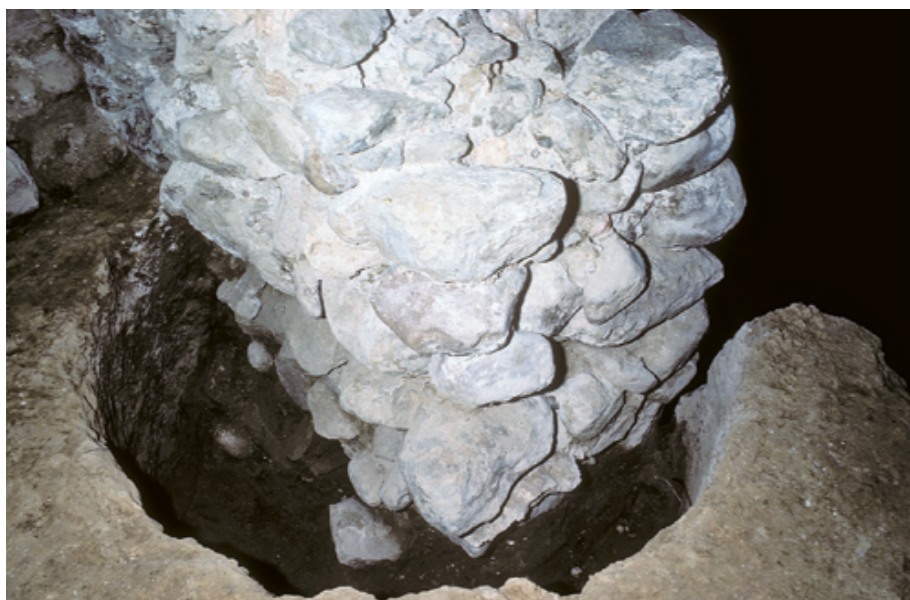
Fig. 13 Fosse-silo circulaire sud comblée par les fondations de l'arc triomphal du XV e siècle.
