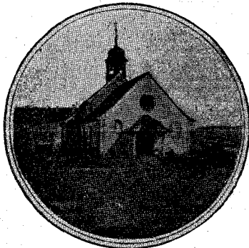
La chapelle de Saint-Pierre peu de temps avant sa démolition.
