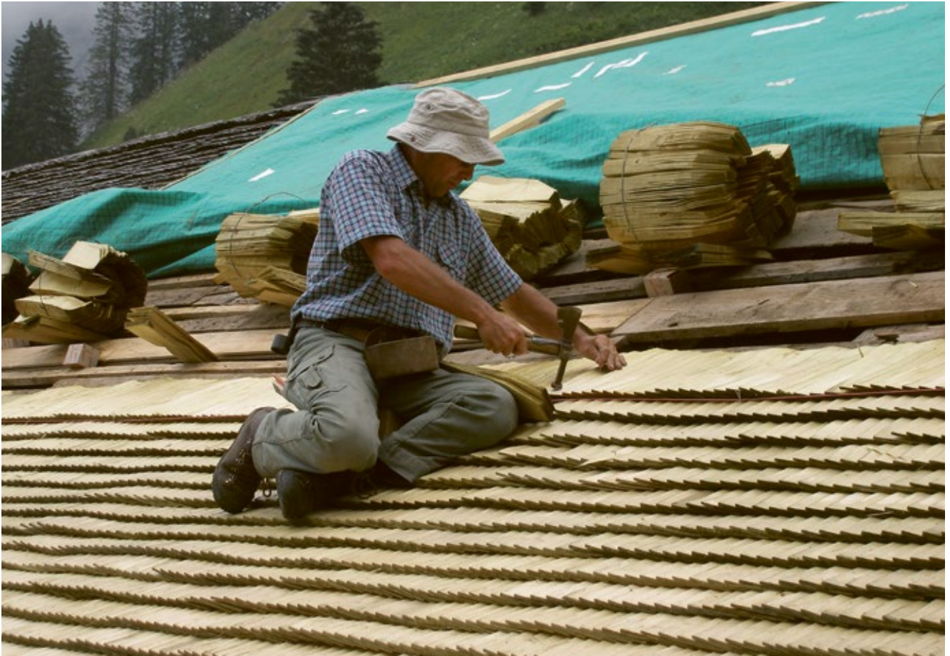
Réfection du toit du chalet de Bounavaux.
